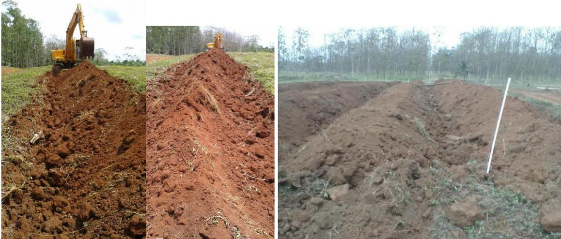
**Figura 2.** Proceso de construcción de los megasurcos
