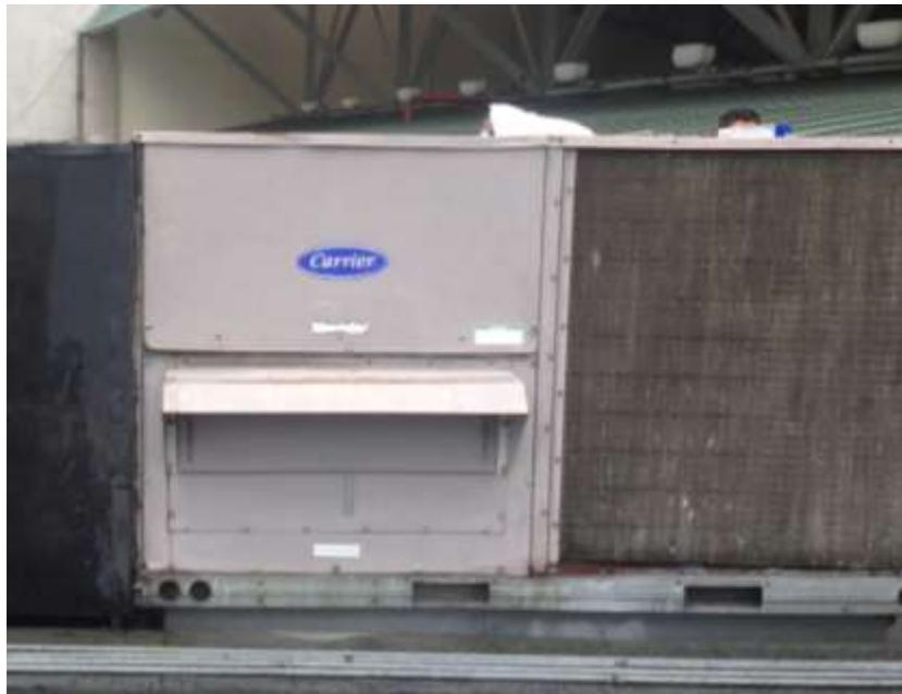
*Figura 3-11. Paquete de aire acondicionado Carrier*
