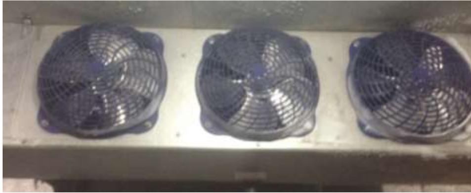
Figura 3-1. Evaporador con abanicos congelados y dañados
