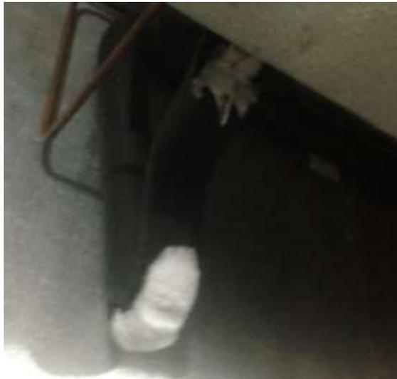
Figura 3-2. Aislamientos en mal estado y con presencia de hielo
