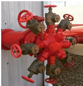
Figura 33: Cabezal para pruebas de flujo de bombas hidráulicas. Fuente: Firepro systems
