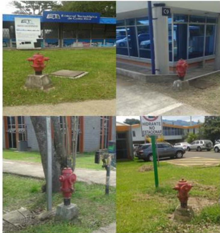
Figura 62: Ubicación de los hidrantes actuales instalados en el TEC. Fuente: Fotografía propia
