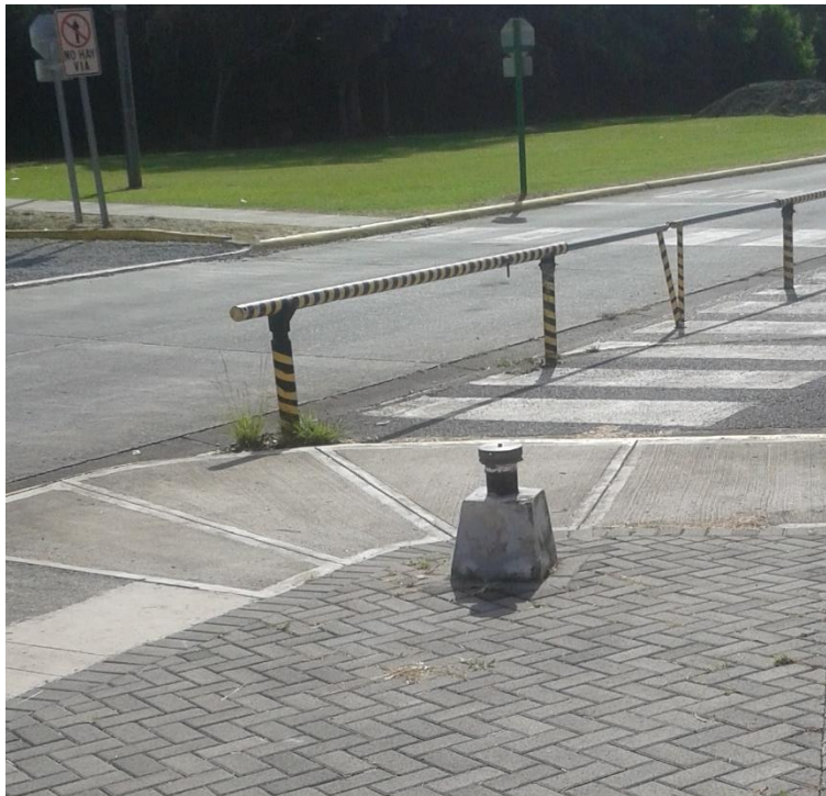
Figura 60: Toma directa para conexión de bomberos instalada en alrededores de la piscina. Fuente: Fotografía propia
