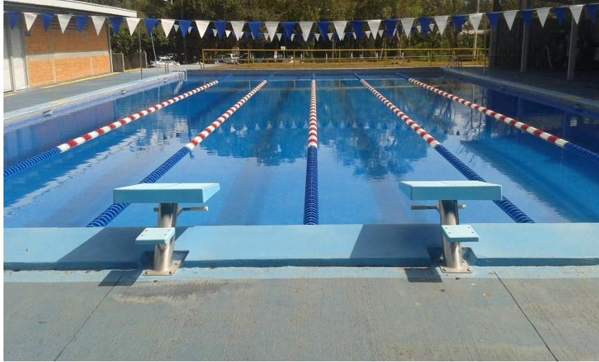
Figura 59: Piscina institucional a utilizar como tanque de almacenamiento de agua. Fuente: Fotografía propia
