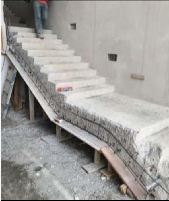
**Figura 59.** Arreglo en gradas donde dejaron de un ancho menor al especificado en planos.
