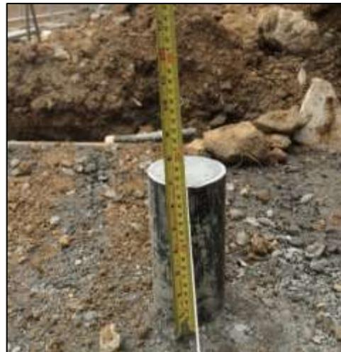
**Figura 38.** Inspección altura de micropilotes.
