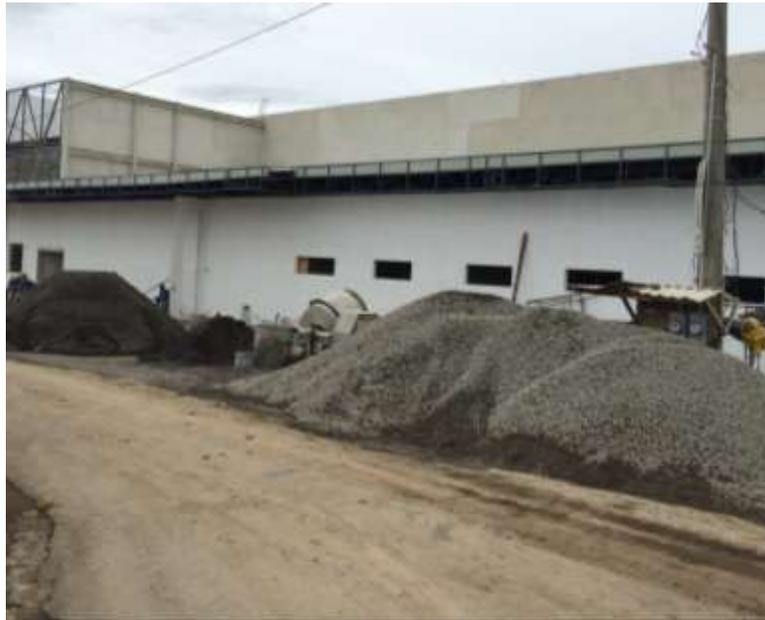
Figura 1. Agregados en vía pública y no les colocaron aislante en la base.
