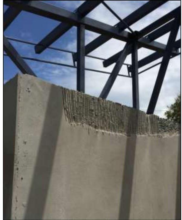
**Figura 25.** Arreglo en nivel de repello.
