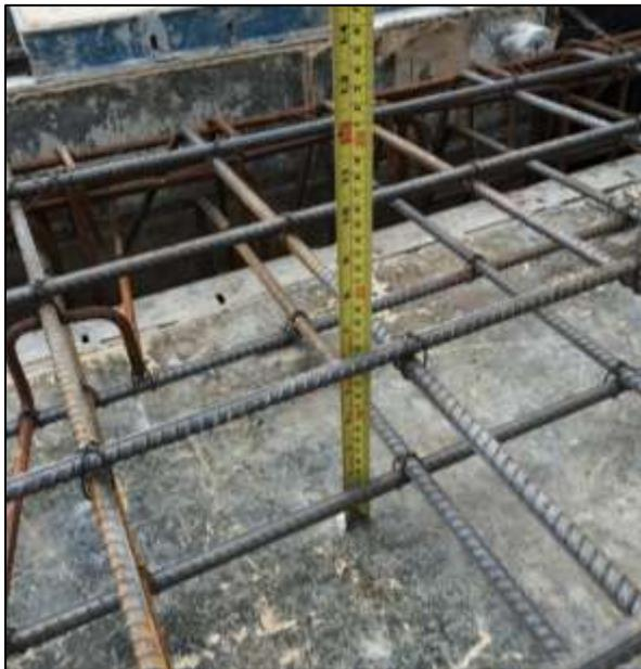
**Figura 10.** Revisión de armadura colocada de la planta de tratamiento.
