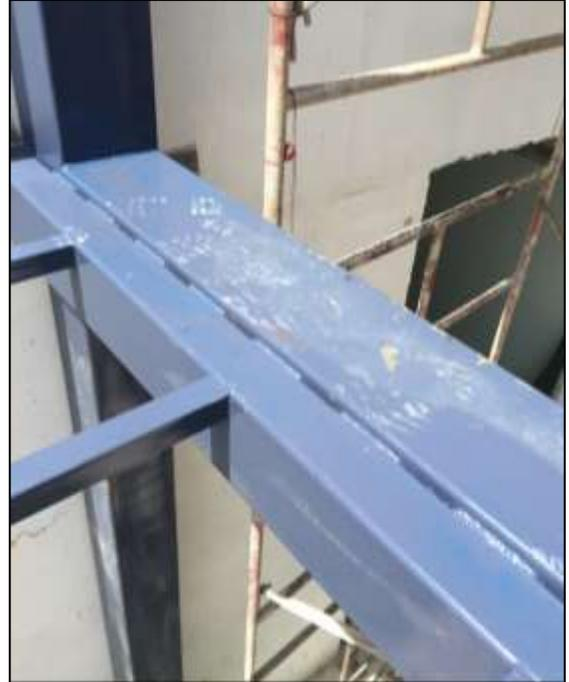
**Figura 44.** Inspección de soldadura, longitudes correctas, aspecto según especificaciones.
