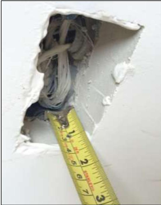
**Figura 55.** Distancia muy grande entre la superficie de pared y caja de instalación eléctrica.
