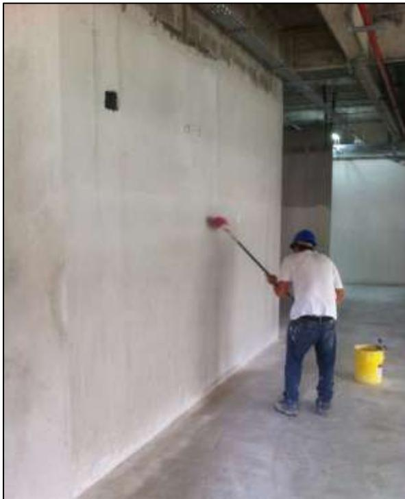
**Figura 24.** Limpieza de pared para colocación de pasta.
