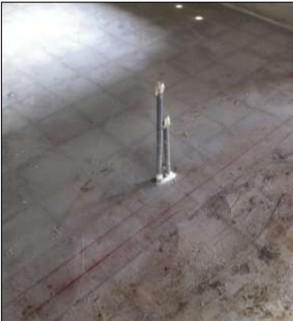
**Figura 27.** Tubos para instalación eléctrica desalineados con el trazo de la pared liviana.
