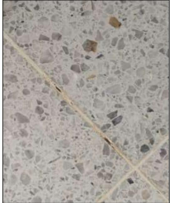
**Figura 61.** Defectos en fragua de piso terrazo en reiteradas ocasiones.
