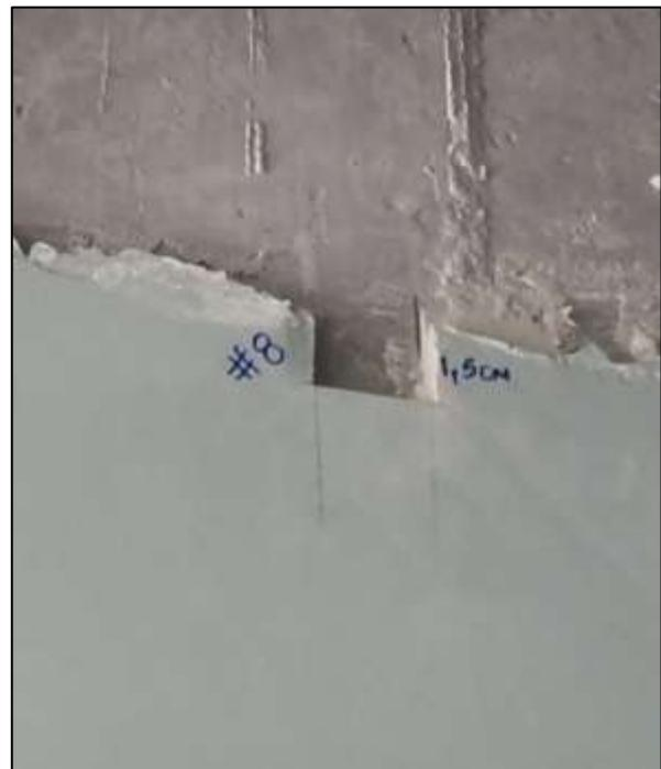
**Figura 26.** Revisión final de grosor de repellos.
