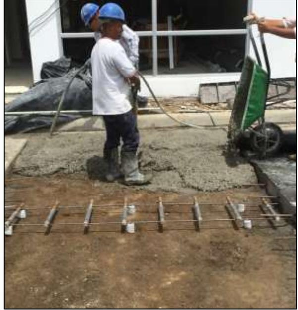
**Figura 18.** Inspección de losas de parqueo, buena utilización de helados, dovelas ubicadas a la distancia correcta, base compactada.
