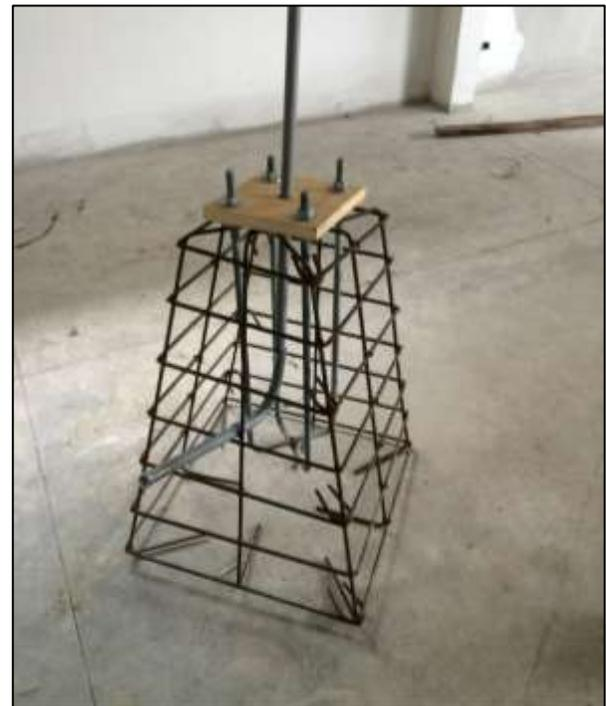
**Figura 58.** Inspección de pedestales para postes de luz.
