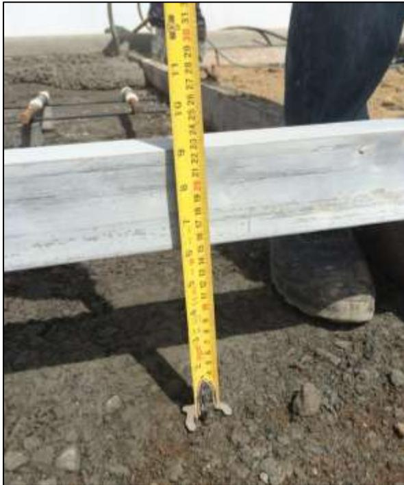
**Figura 17.** Inspección grosor de losas de parqueo.
