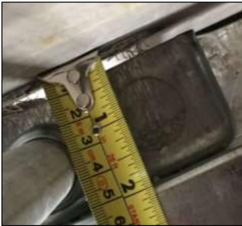
**Figura 35.** Inspección de distancia entre caja de tomas y la lámina de Durock, no debe ser mayor a 1 cm.
