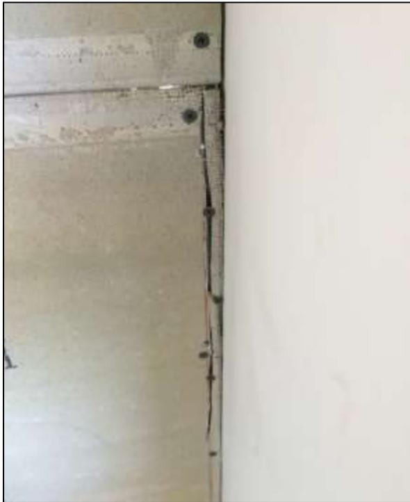
**Figura 31.** Grietas en láminas de Durock.
