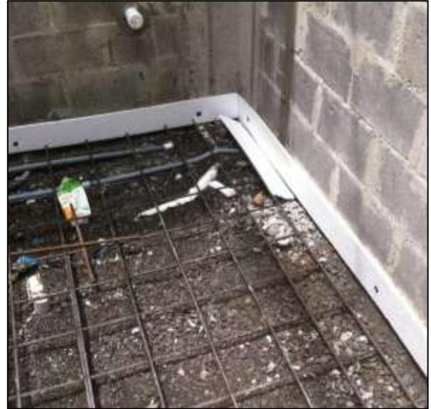
**Figura 15.** Malla tocando la base, contaminación, falta de helados.
