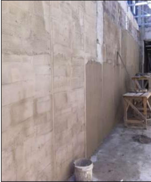
**Figura 23.** Repello en proceso de pared en mampostería.
