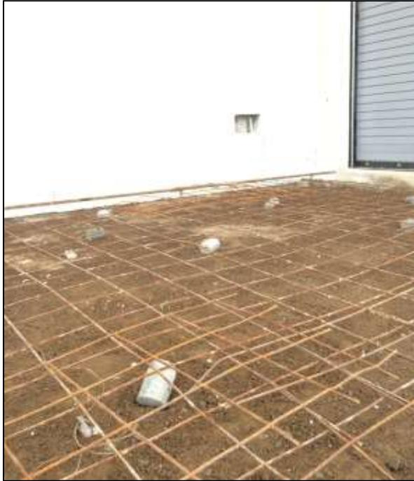
**Figura 13.** Malla en malas condiciones, herrumbrada y doblada, mal uso de helados.
