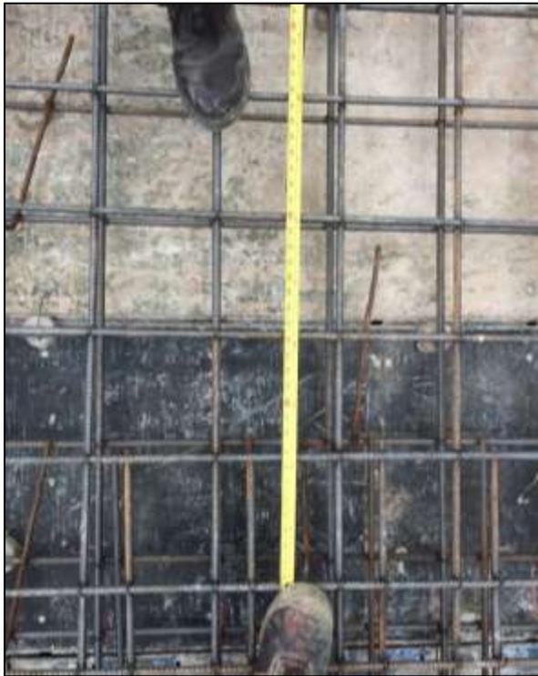
**Figura 9.** Revisión de armadura colocada de la planta de tratamiento.
