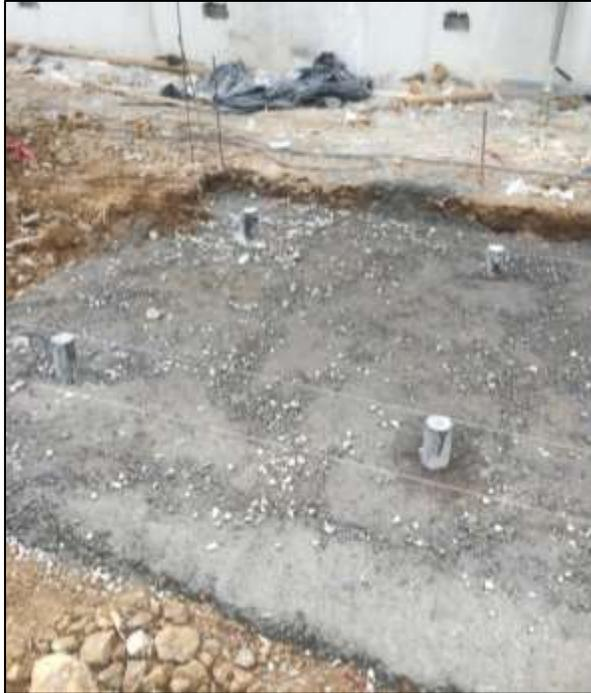
**Figura 39.** Inspección de alineación de micro pilotes para la base de escaleras de emergencia.
