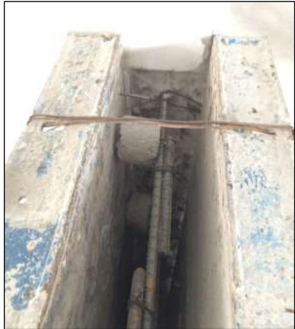
**Figura 11.** Inspección, uso correcto de helados, formaleta, armadura.
