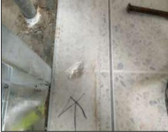
**Figura 34.** Daño provocado al terrazo, por colocación de la estructura base para las paredes livianas.
