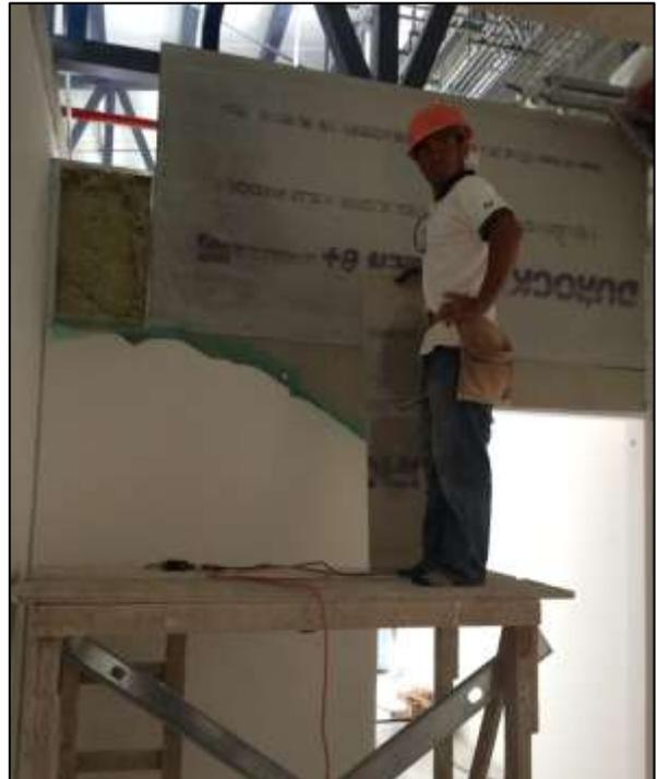
**Figura 33.** Colocación de fibra en pared liviana cortafuegos.
