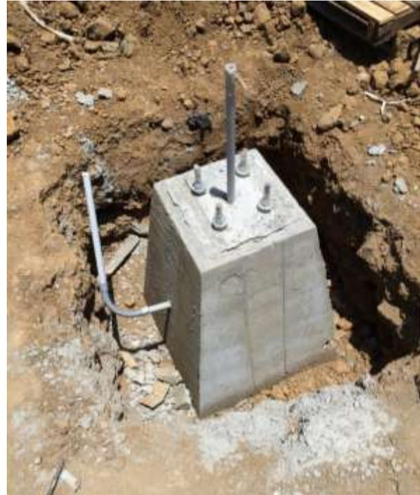
**Figura 57.** Inspección de pedestales para postes de luz.
