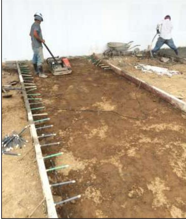
**Figura 16.** Compactación de superficie para losa de parqueos.
