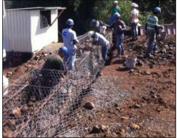
**Figura 48.** Colocación de gaviones.
