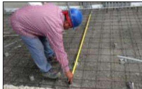
**Figura 8.** Inspección malla colocada.
