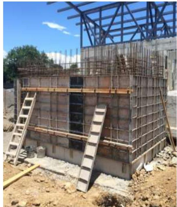
**Figura 54.** Formaleta colocada planta de tratamiento.
