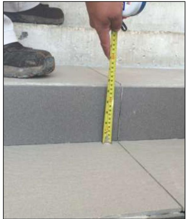
**Figura 62.** Revisión altura de grada.
