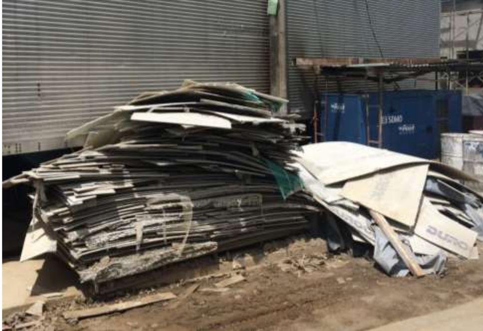
Figura 5. Desperdicios grandes de material (Durock)
