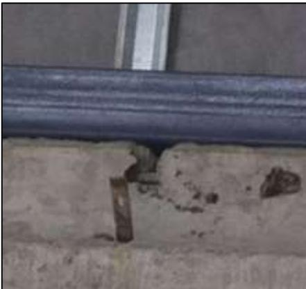
**Figura 52.** Error en colado de concreto, varilla expuesta.
