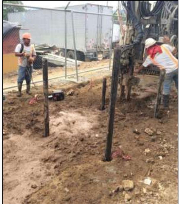
**Figura 37.** Proceso de colocación de micro pilotes para la base de escaleras de emergencia.
