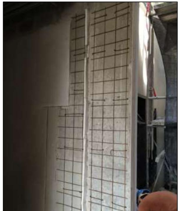
**Figura 22.** Reparación de repello.
