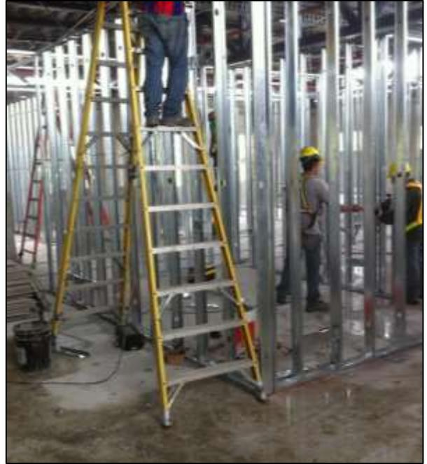
**Figura 28.** Colocación de estructura para paredes livianas.
