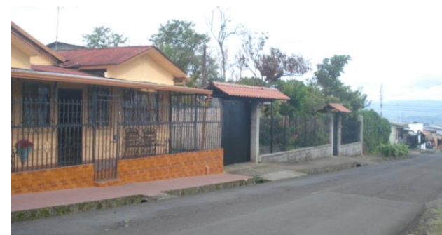
Viviendas de San Isidro. Edificaciones de un nivel (sólido gris claro), la mayoría de las construcciones son de un nivel, se respeta la escala humana. Fuente: Elaboración propia
