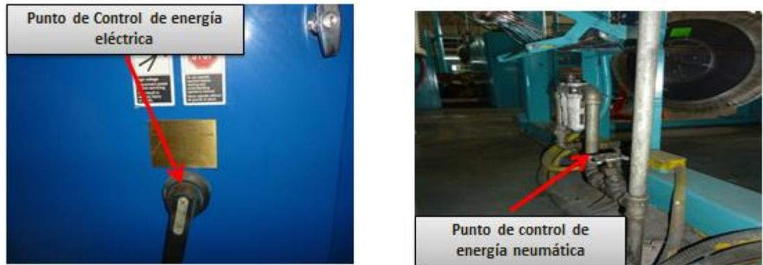
Figura Q: Puntos de control de energía eléctrica y neumática
