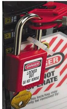
Figura P: Bloqueo y etiquetado de energía eléctrica
