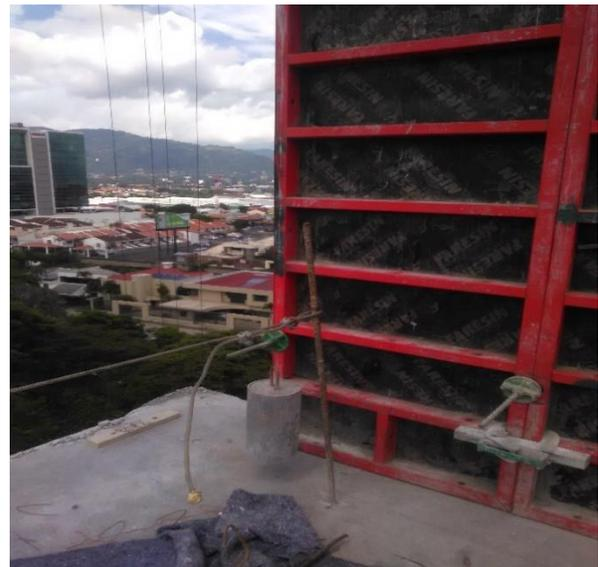
**Figura 5.** Panel de 2,70x0, 90x0, 10 (figura con fines ilustrativos)
