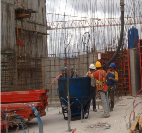
**Figura 3.** Balde de 1 m<sup>3</sup> utilizado en el proyecto.
