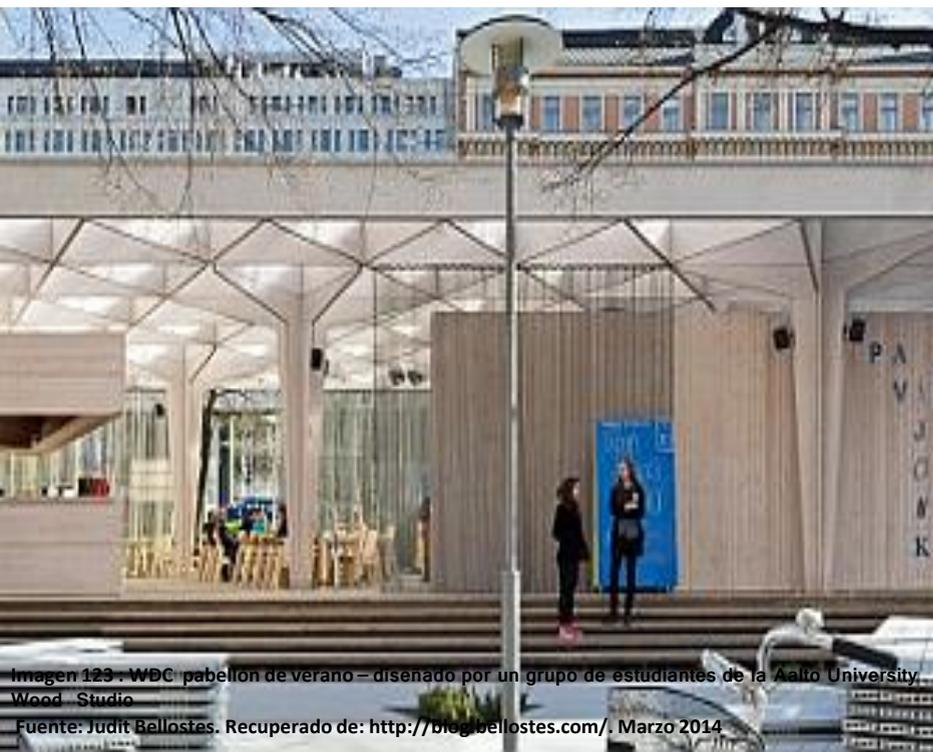
El pabellón está construido en madera finlandesa y láminas de policarbonato celular doble pared provista de protección contra los rayos ultravioletas en su cara exterior, y debido a su doble pared, ofrece un buen aislamiento térmico, una gran rigidez estructural y un peso ligero.
