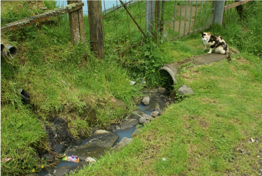
Figura 5.3. Descarga de agua residual gris a escorrentía sin canalización formal.
