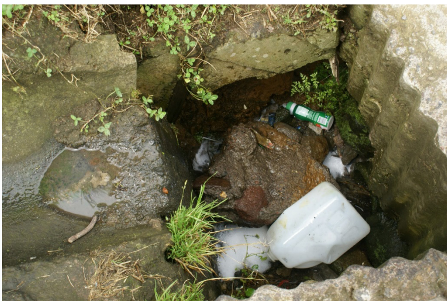
Figura 5.2. Descarga de agua residual gris a sistema de recolección agua lluvia con residuos sólidos acarreados.
