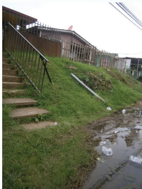
Figura 5.2. Descarga de agua residual sin canalización.
