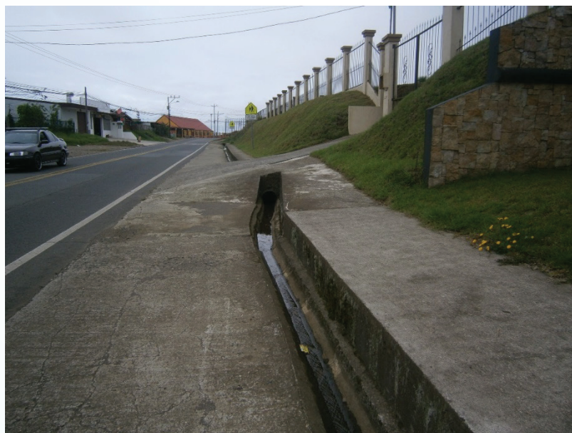
Figura 5.1. Descarga de agua residual en sistema de recolección de agua de lluvia.
