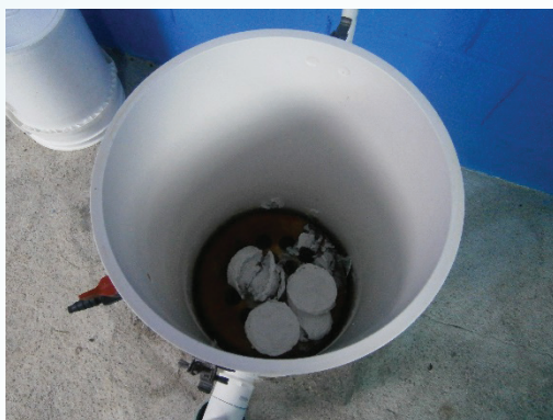
Figura 5.13 Sistema de desinfección presente en los acueductos evaluados Cantón Turrialba.
