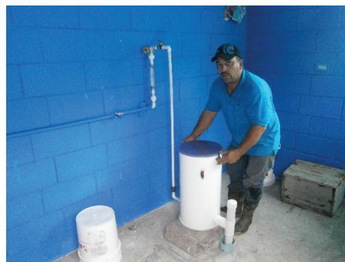
Figura 5.13 Sistema de desinfección presente en los acueductos evaluados Cantón Turrialba.
