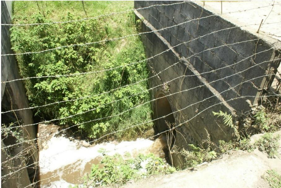
**Figura 5.19. Recolección de aguas residuales en alcantarillado pluvial.**
