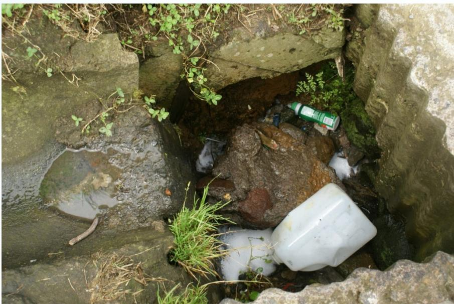
**Figura 5.27.** Descarga de agua residual gris a sistema de recolección agua lluvia con residuos sólidos acarreados.
