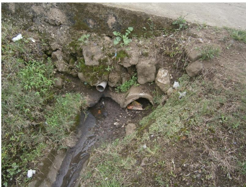
Figura 5.25. Contaminación de agua pluvial con agua gris, filtración en suelo.
