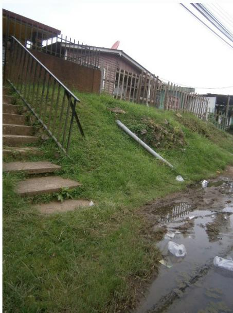
Figura 5.24. Descarga de agua residual sin canalización.
