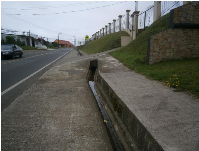
Figura 5.23. Descarga de agua residual en sistema de recolección de agua de lluvia.
