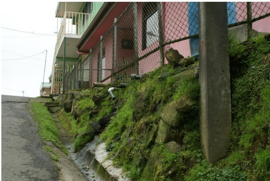
Figura 5.26. Descarga de agua residual gris a sistema de recolección agua lluvia.
