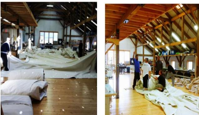
Figura 47 Doblado de membrana.
