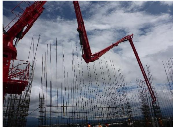
*Figura 16. Colado de entrepiso utilizando placing boom.*
