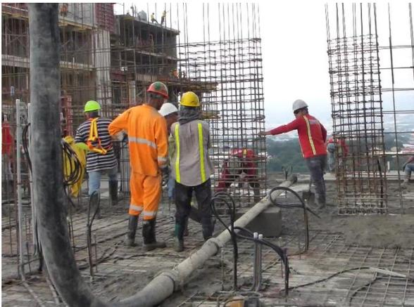
*Figura 15. Colado de entrepiso utilizando bomba telescópica para torre sur.*
