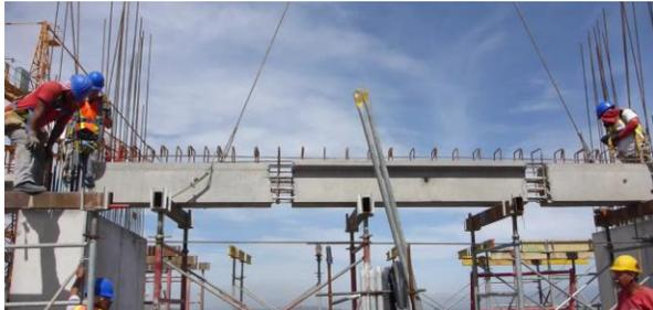
Figura 10. Montaje de vigas prefabricadas.
