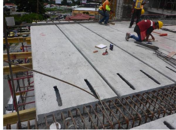
Figura 11. Montaje de losas prefabricadas.
