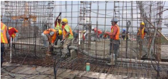
*Figura 14. Colado de entrepiso utilizando bomba estacionaria para torre norte.*
