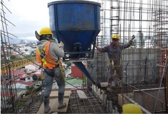
*Figura 13. Colado de entrepiso con el método de descarga directa con balde.*
