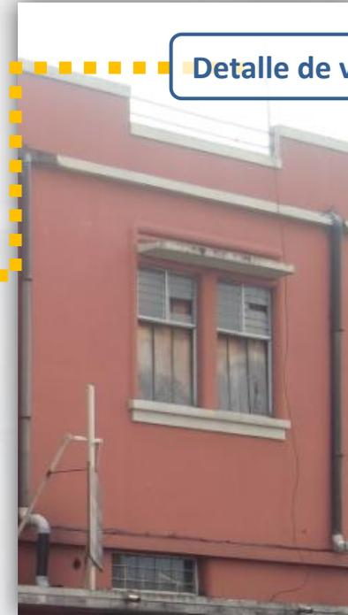
Como parte del movimiento Art Deco se resalta el techo oculto, remates geométricos en las partes altas de las paredes y voladizos en la parte superior de las ventanas.
