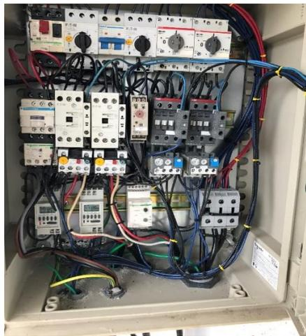
Figura 31. Tablero de control de los sistemas de aireación y agitación de las lagunas de tratamiento Fuente: Elaboración propia
