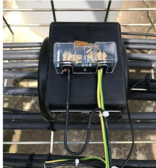
Figura 38. Transformadores de corriente instalados en secundario de transformación del generador.
