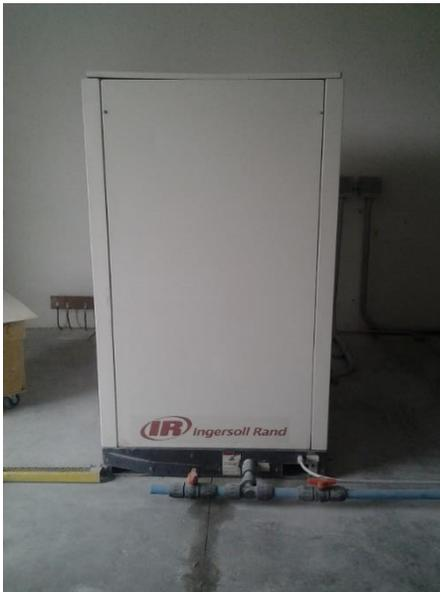
**Figura 32. Compresor de tornillo**
