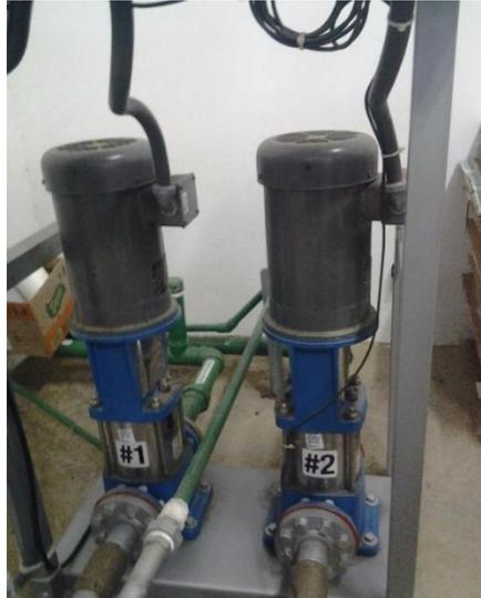
**Figura 31. Bomba de agua alternante**
