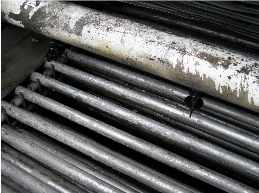
**Figura 3.5.** Banco de tubos alternados del intercambiador de calor
