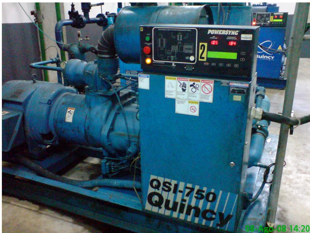
Figura 3.1. Sala de compresores de aire
