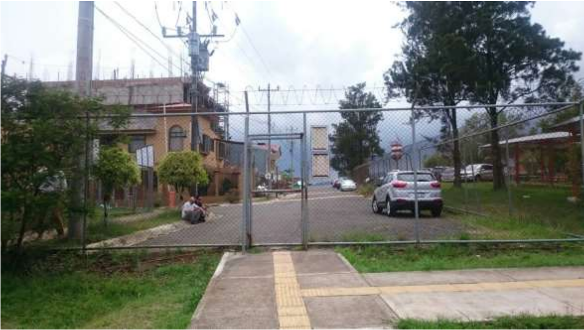
Figura 22. Estado del acceso “Portón Escuela de Materiales/Producción Industrial”
