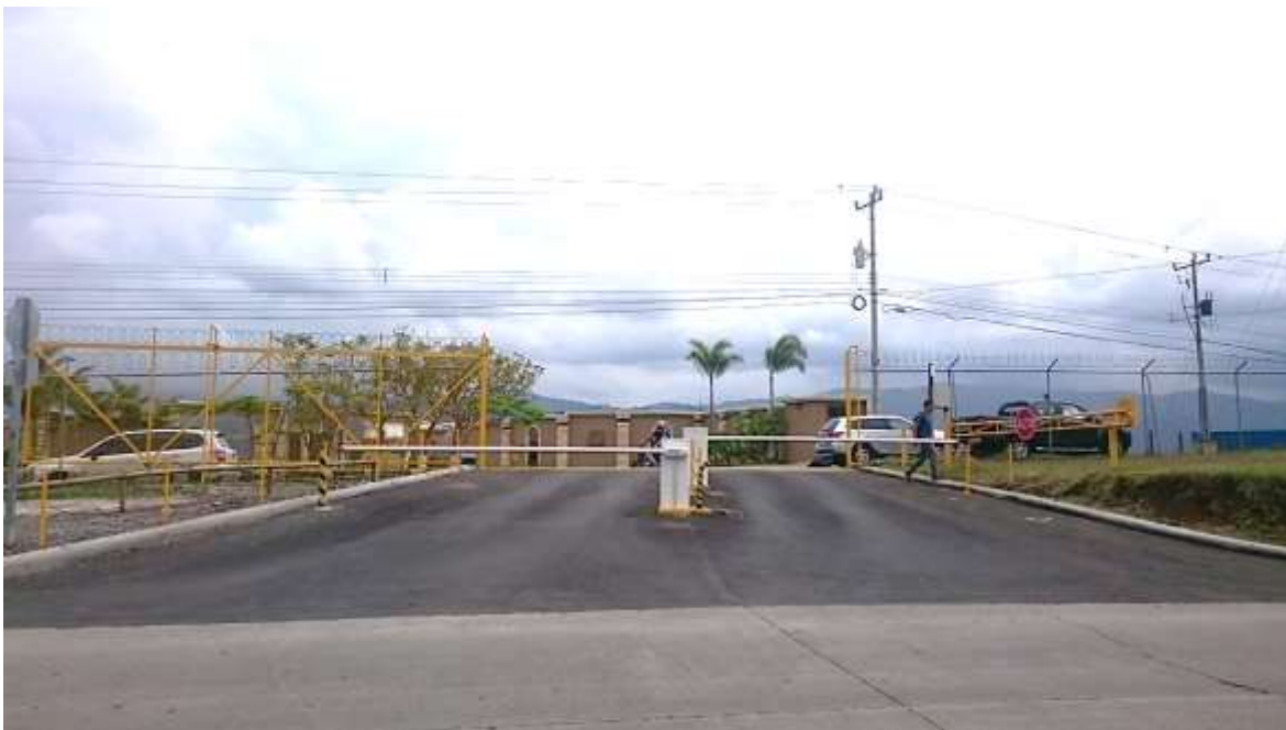
Figura 21. Estado del acceso “Entrada Portón detrás del CEQIATEC”.
