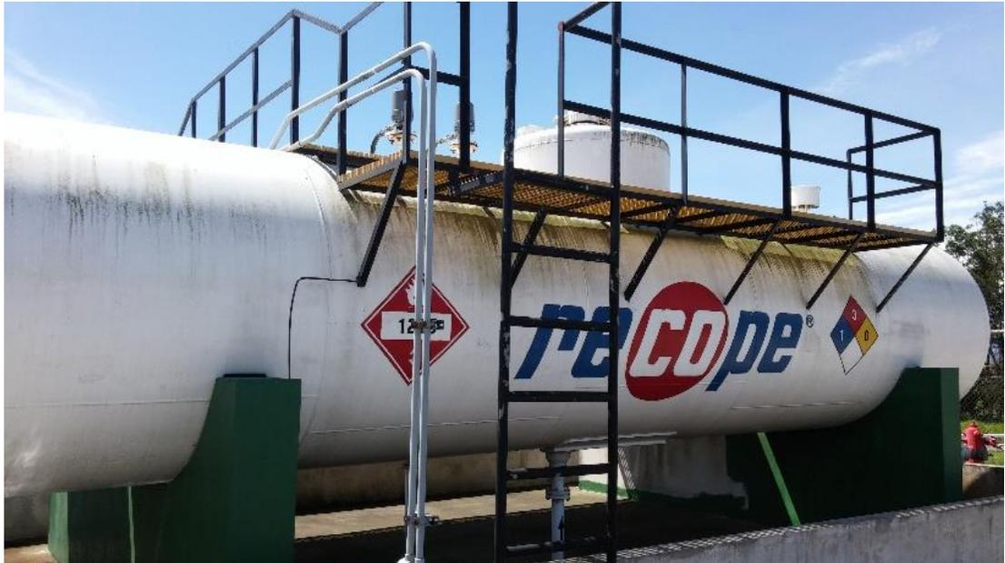
**Figura 5.1.** Tanques de almacenamiento de residuos de hidrocarburos.
