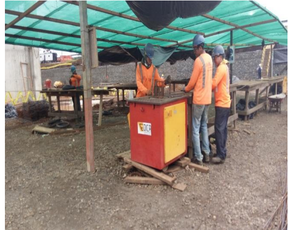
Figura 17. Taller de armadura donde se preparan las mallas a utilizar en contrapiso.
