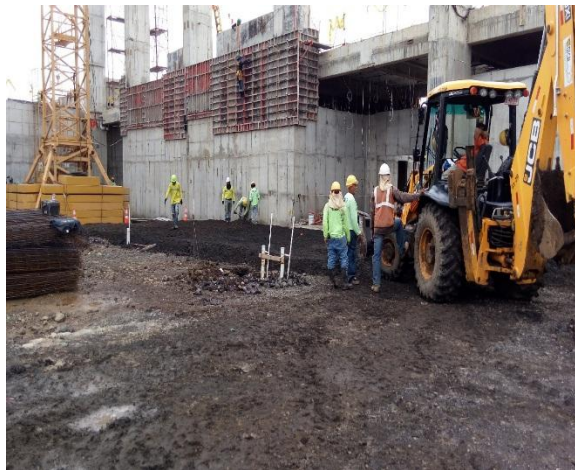
Figura 19. Terreno nivelado y colocación de lastre como base de contrapiso.
