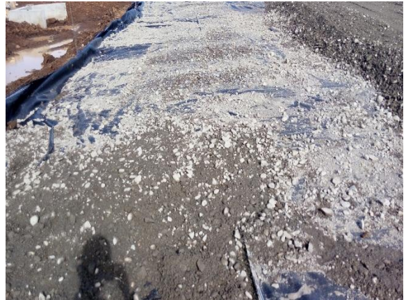
Figura 8. Colocación de geotextil posterior al corte y nivelación.
