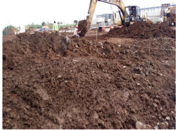
Figura 7. Terreno antes de su preparación con máquina realizando corte
