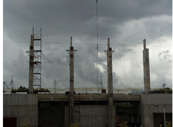
Figura 11. Salón de exhibiciones antes de la colocación de la armadura de techo.
