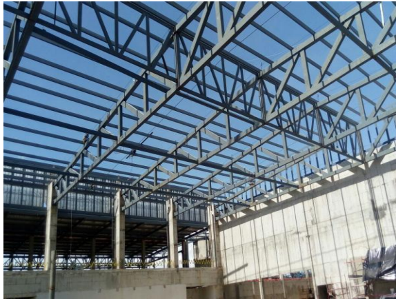
Figura 15. Estructura de techo principal y secundaria colocada.
