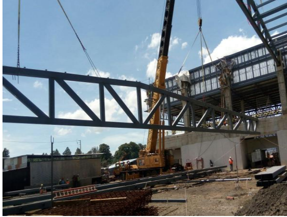
Figura 14. Montaje de cerchas principales de 54 metro en el salón principal de exhibiciones
