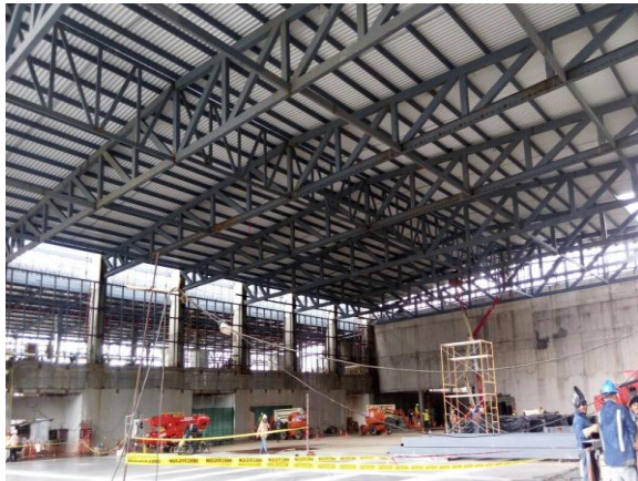
Figura 16. Estructura de techo y cerramiento concluidos.
