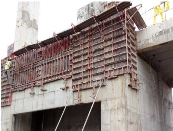
Figura 6. Formaleta colocada en sitio para colada de muro de concreto.
