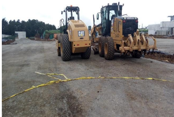
Figura 10. Terreno conformado y compactado, listo para colocación de capas posteriores.
