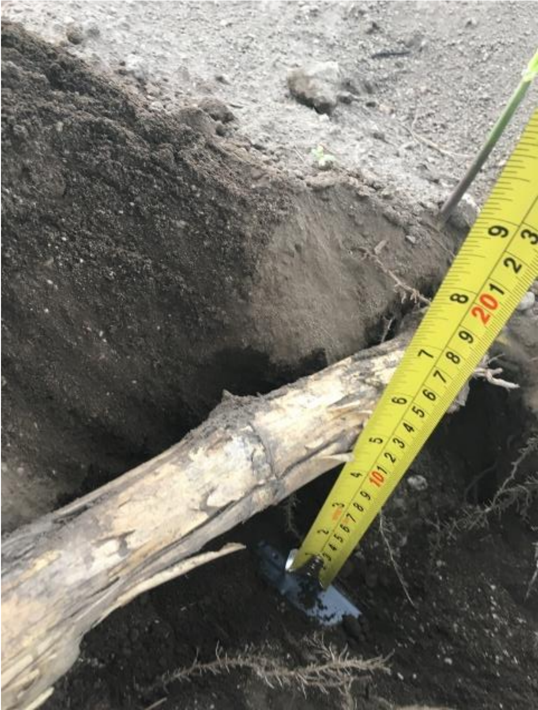
Figura 43 Profundidad de instalación de la cinta de goteo
