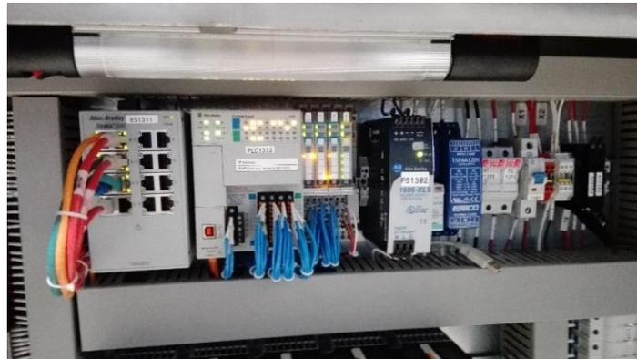
*Ilustración 17. PLC y fuente de poder. Adaptado de la Gerencia de Operaciones de Ficmams, octubre 2017.*
