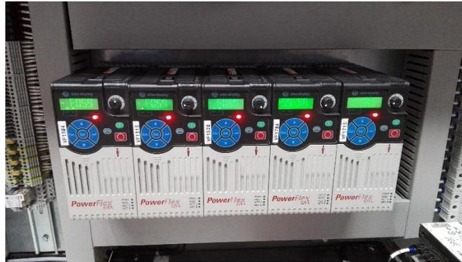
*Ilustración 18.* Variadores de frecuencia. Adaptado de la Gerencia de Operaciones de Ficmams, octubre 2017.
