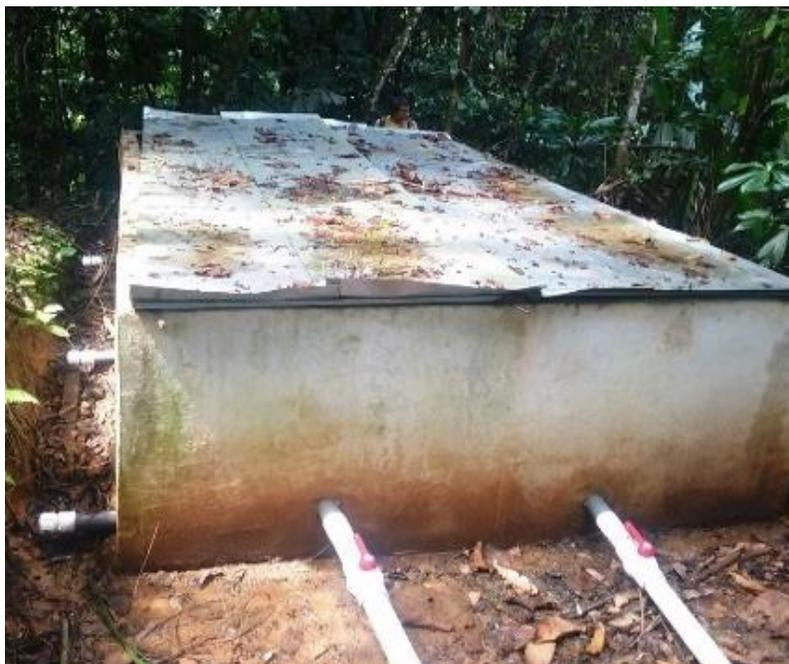
**Figura 5.1-3. Tanque de sedimentación del acueducto, con tapa de zinc metálico**
