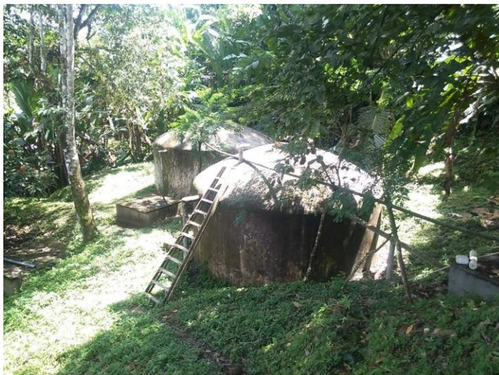
**Figura 5.1-4. Tanques de almacenamiento en forma de botella**
