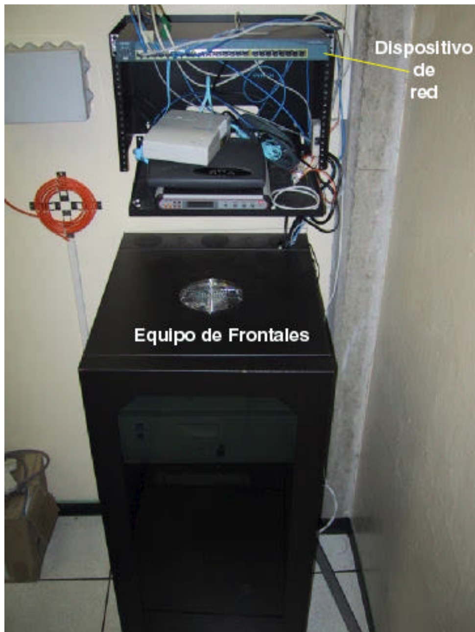
Figura 7.6.1 Equipo de frontales instalado en la central digital Alcatel de Desamparados
