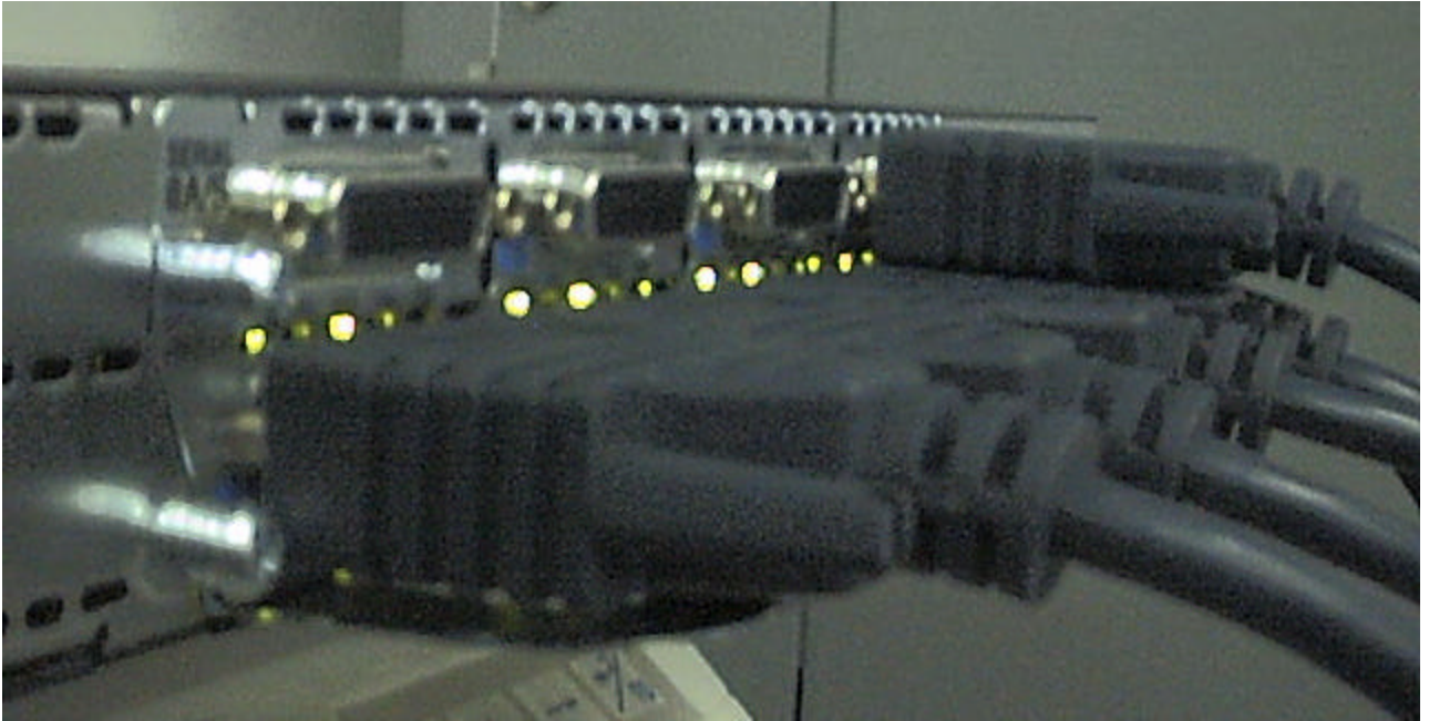
Figura 7.12.2 Módulo de red del router 3620, con 5 de los 8 puertos utilizados
