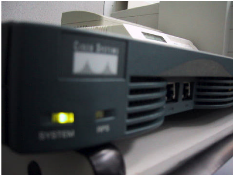
Figura 7.12.1 Router Cisco 3620, instalado en el piso 4 del edificio ICE San Pedro
