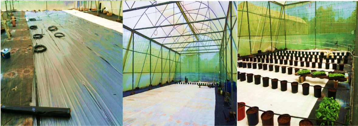
Figura 5. Sistema de riego instalado dentro del invernadero para el proyecto de investigación de tres cultivares de pepino ( Cucumis sativus . L) bajo ambiente protegido en sistema hidropónico abierto con dos soluciones nutritivas en San Carlos, Costa Rica 2015-2016.
