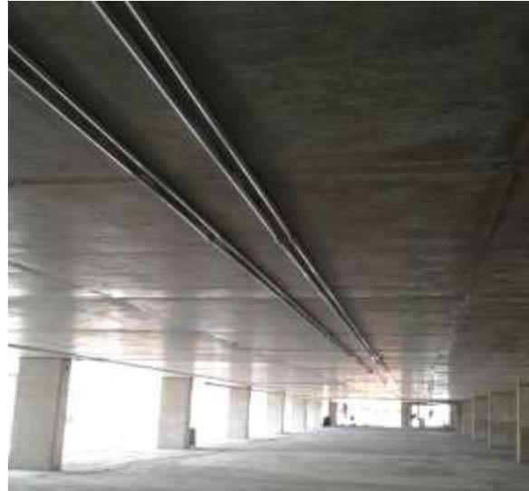
**Figura 10.** Colocación de tubería para los sistemas de tomacorrientes e iluminación.
