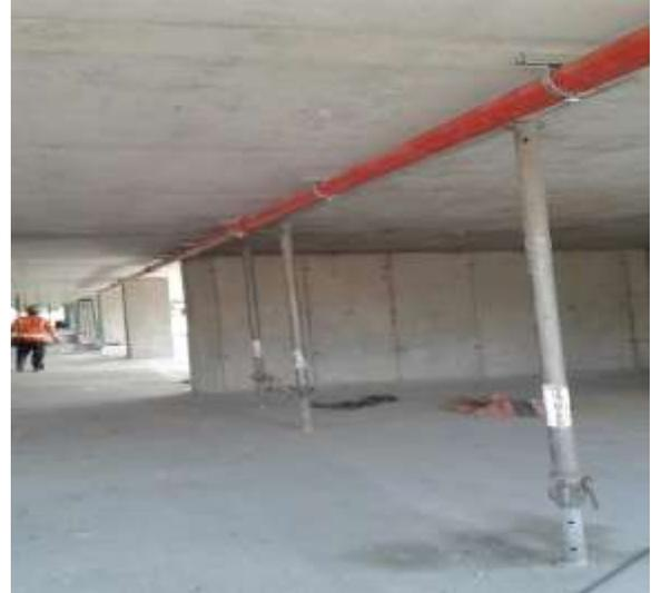
**Figura 12.** Colocación de tubería para el sistema de supresión.
