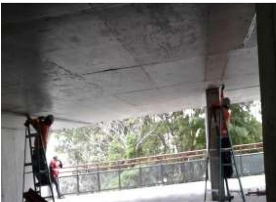
**Figura 9.** Demarcación de línea guía para canalización de los sistemas de tomacorrientes e iluminación.
