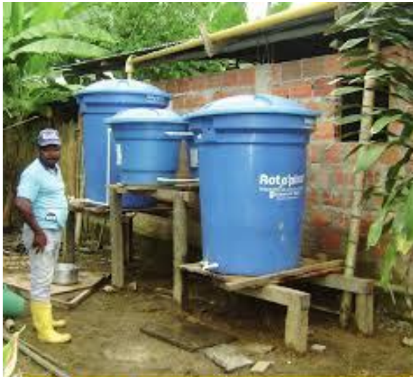
Figura 2: Tanque plástico elevado. Fuente: elhuertoenlaciudad.wordpress.com
