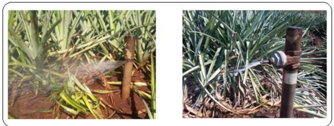
Fotografía 10. Se presentan fugas en los elevadores en algunos sectores de la finca Fuente: Elaboración propia, 2017
