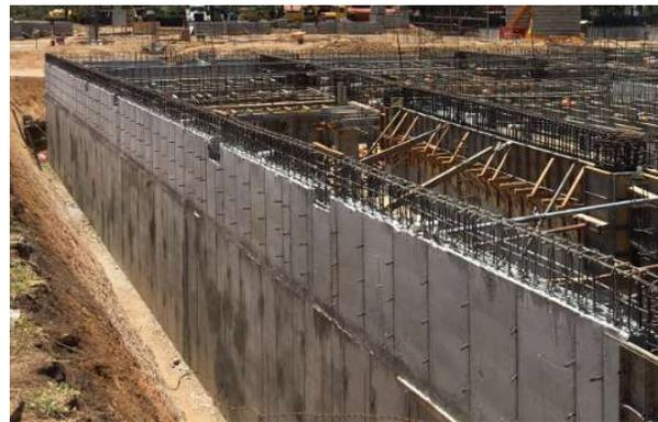
Figura 31. Muros colados en sótano. Fotografía: investigador.
