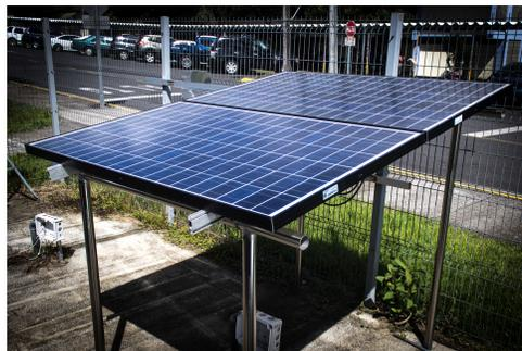
Figura 6: Estructura de montaje con inclinación fija
