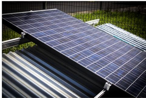
Figura 5: Estructura de montaje tipo cercha
