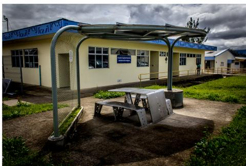
Figura 20: Fotografía del kiosco fotovoltaico aislado Foliage. Kiosco utilizado para que estudiantes y profesores utilicen dispositivos electrónicos en entornos naturales sin conexión a la red eléctrica principal.
