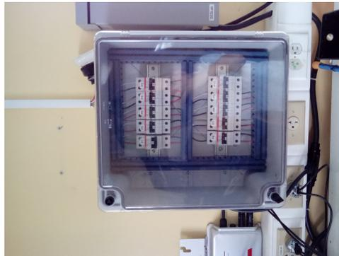
Figura 10: Caja eléctrica con protecciones para cada una de las terminales de los módulos FV
