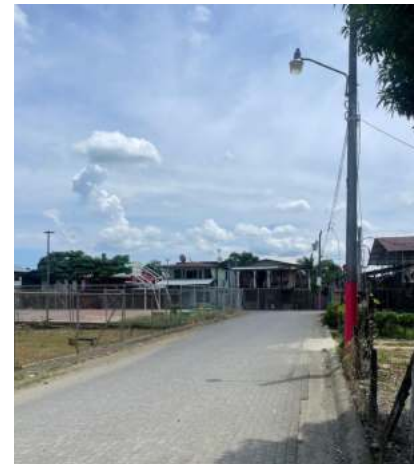
Figura 3.26 Imagen propia de postes de luz
