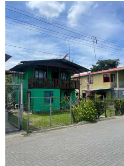
Figura 3.46 Imagen propia de vivienda en Estrada
