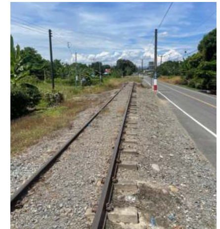
Figura 3.27 Imagen propia de tendido eléctrico
