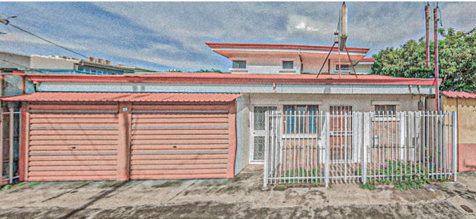
Figura 3.10 Vivienda del casco central de Barva.
