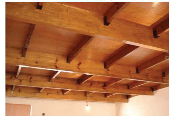
Entrepiso de madera Pino amarillo del sur, con vigas de 15cm x 40cm de peralte, viguetas de 5 x 15cm @ 60cm
