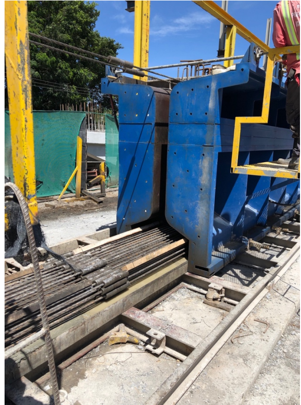
Fotografía 12. Tensado de torones.
