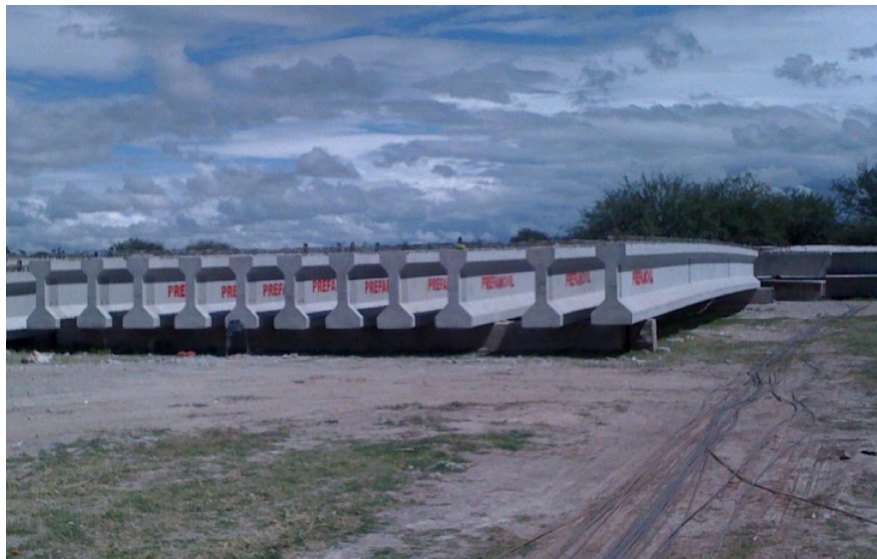
Figura 12. Almacenamiento e identificación de elementos prefabricados. Fuente: Obtenido de Argueta (2010).
