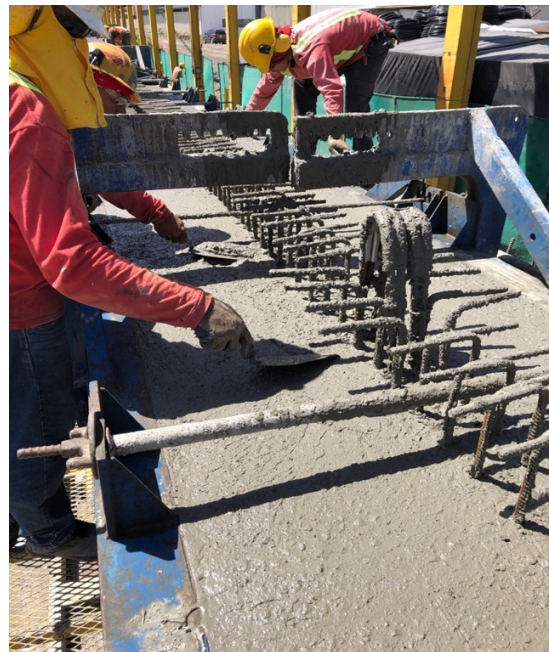
Fotografía 16. Detallado de la cara superior de la viga.
