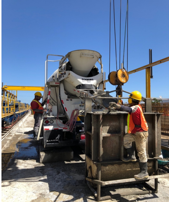
Fotografía 13. Depósito del concreto en el balde, para transportarlo al molde de la viga.
