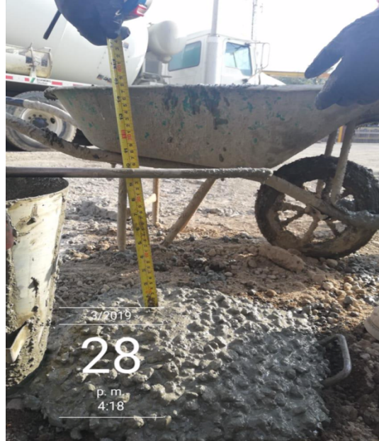
Fotografía 18. Prueba de revenimiento del concreto para un dintel.
