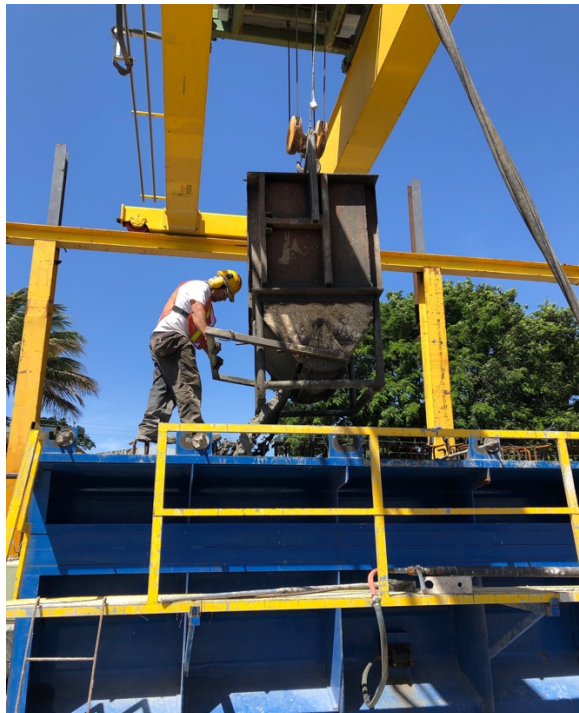
Fotografía 14. Depósito de concreto en el molde de la viga a una altura considerable.
