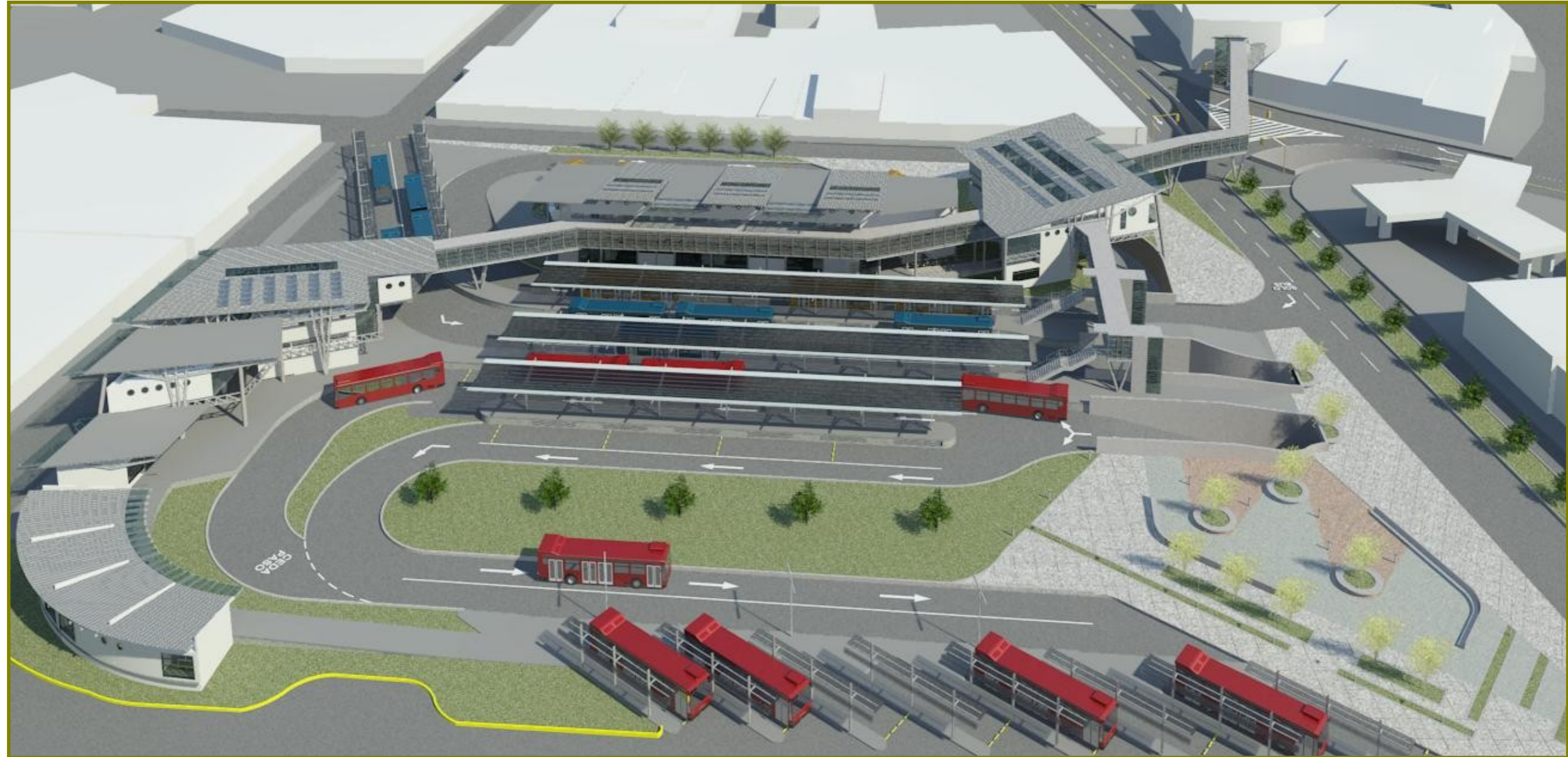
Imagen 132_Vista aérea de la Subestación
