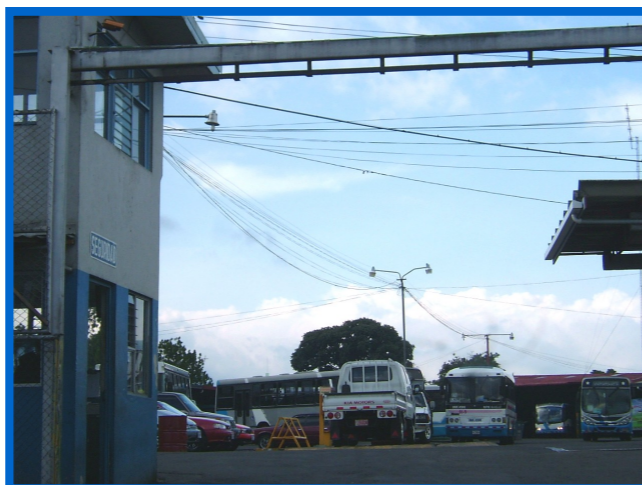
Imagen 64_Área de mantenimiento del plantel actual de los autobuses de Guadalupe
