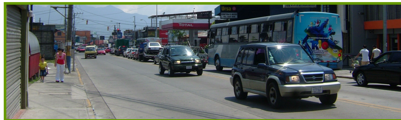
Imagen 10_ Calle de concreto en la vía principal de Guadalupe
