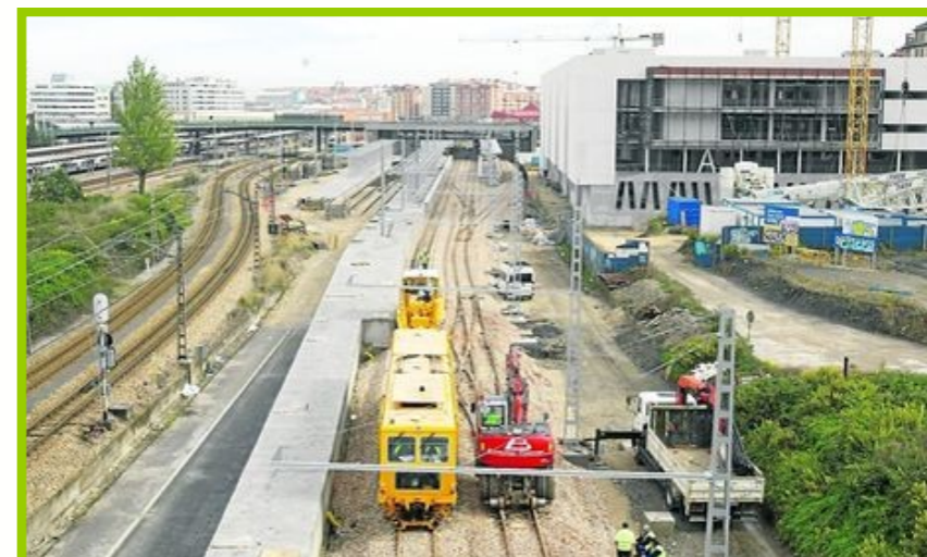
Imagen 20_Estación provisional durante las obras de construcción
