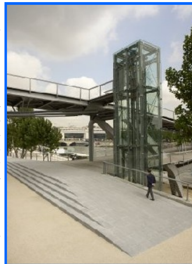
Imagen 44_Elevador autosoportado para puentes peatonales. París
