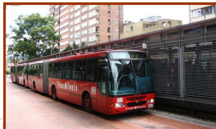
Imagen 23_Infraestructura de abordaje de Transmilenio
