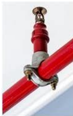
Figura 16. Rociador Montante.
