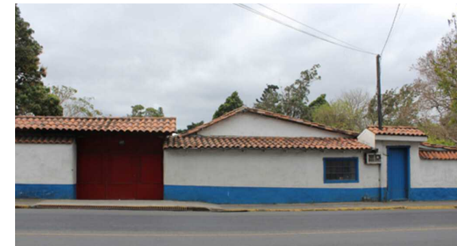
Imagen C2.15 Casa de adobe con techo de teja
