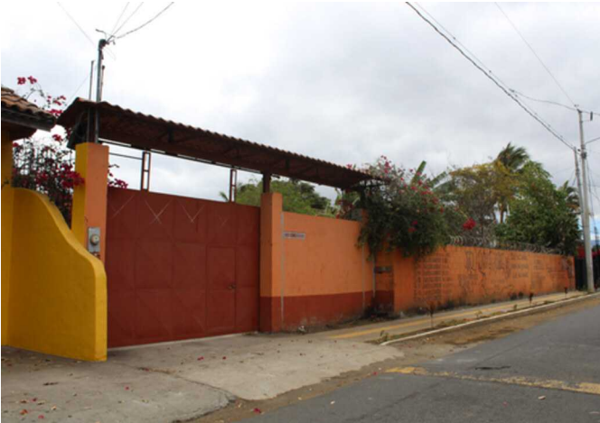
Imagen C4.5 Centro comunitario Casa Adobe
