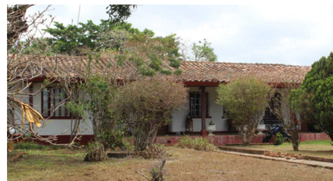
Imagen C2.10 La vivienda posee un amplio corredor que da a un antejardín
