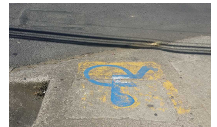
Imagen C2.27 Segmento 23, rampa calle - acera
