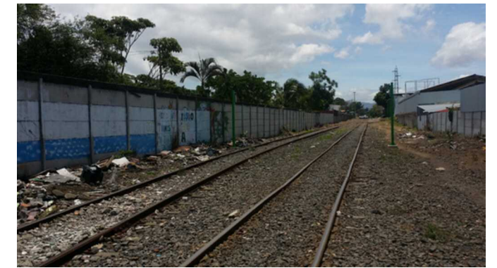
Imagen C4.3 Espacios adyacentes a la vía del tren
