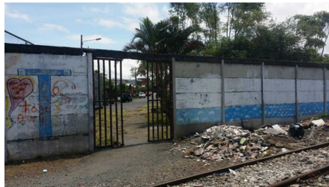
Imagen C2.70 Vista desde la línea del tren
