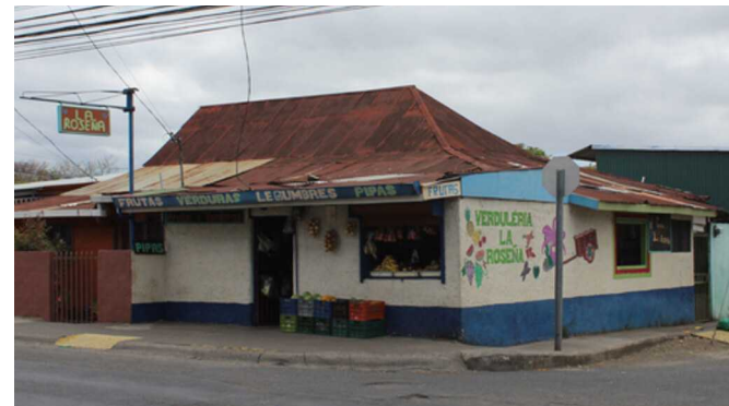
Imagen C2.19 Edificación utilizada como verdulería
