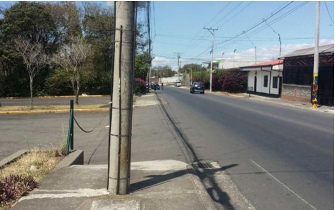
Imagen C2.30 Segmento 51, poste de luz que obstruye el paso
