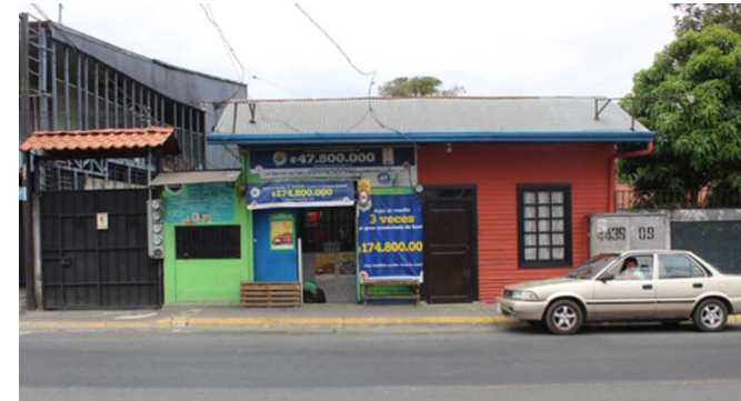
Imagen C2.14 Edificio comercial de madera
