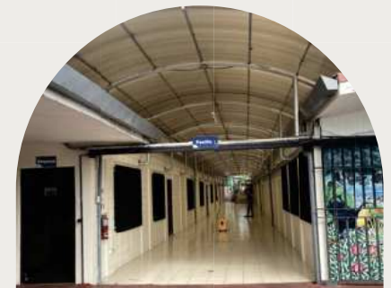
Figura 64. Barrotes existentes Fuente: Elaboración propia
