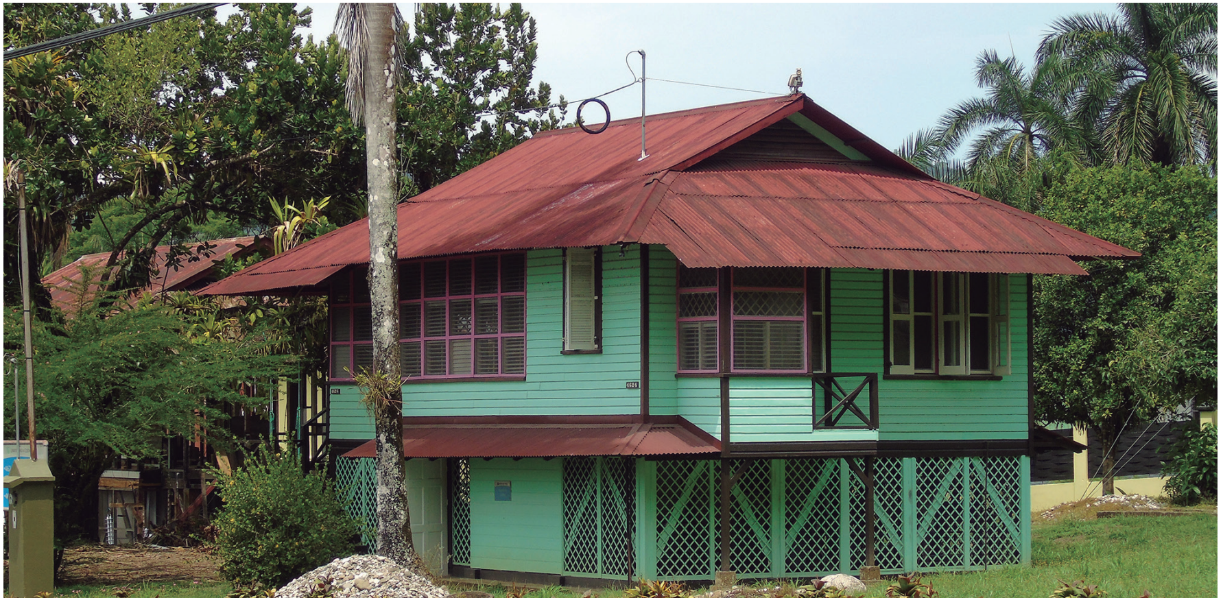
Imagen 96. Estilo victoriano, contexto del Recinto. Fuente propia.
