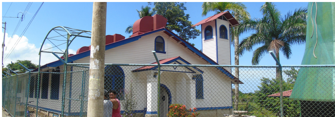
Imagen 45. Iglesia Católica. Fuente propia.
