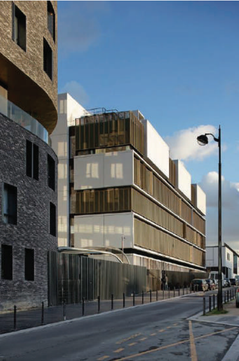
Imagen 26: Vista exterior,, relación con el contexto Fuente: Plataforma arquitectura
