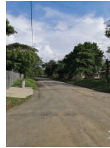
Imagen 33: Calle lateral derecha pública Fuente: Propia
