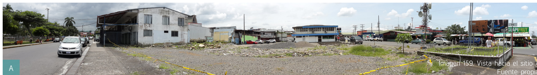
Imagen 158. Vista desde el sitio 2. Fuente: propia.
