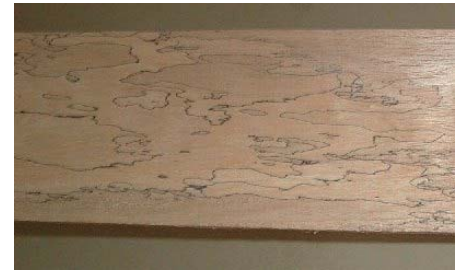
Madera que ha estado por mucho tiempo en contacto con el suelo, afectada por hongos de pudrición
