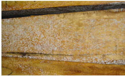
Desarrollo de hongos superficiales en madera que ha estado cubierta durante la difusión de boro.
