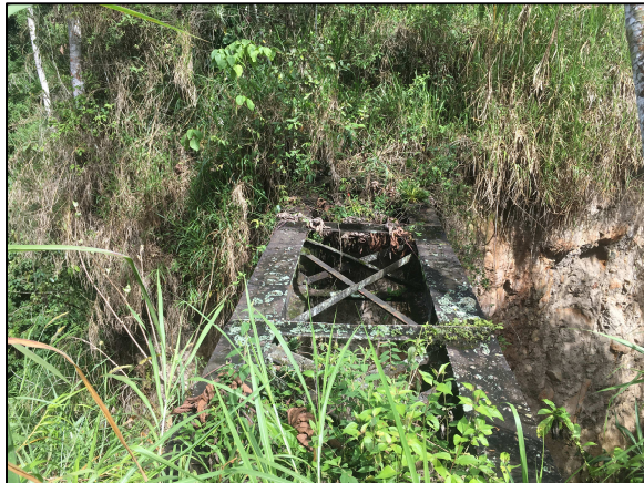
Figura 52. Punto 51. Puente sin bastiones, Santa Marta.
