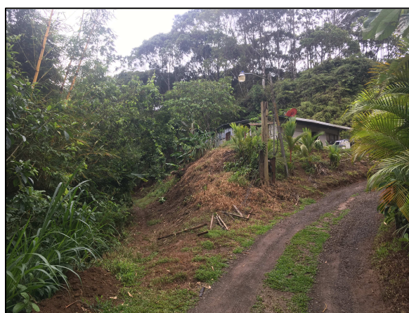
Figura 71. Punto 155. Vivienda construida, en apariencia, sobre derrumbe y derecho de vía.
