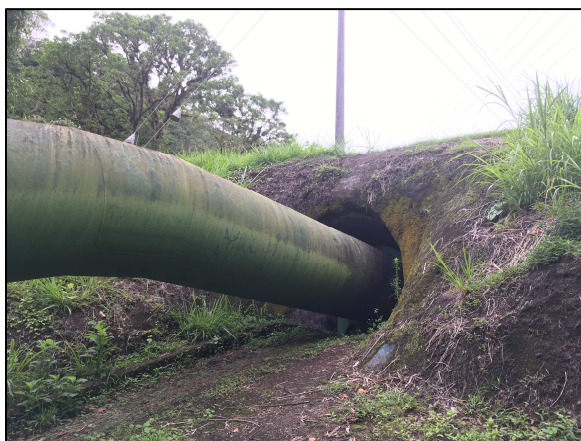
Figura 37. Punto 22. Paso de vía férrea sobre TAP PH Birrís.
