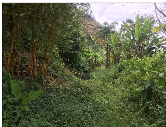
Figura 56. Punto 64. Derrumbes en la vía e invasión de cultivos. Rieles inexistentes.
