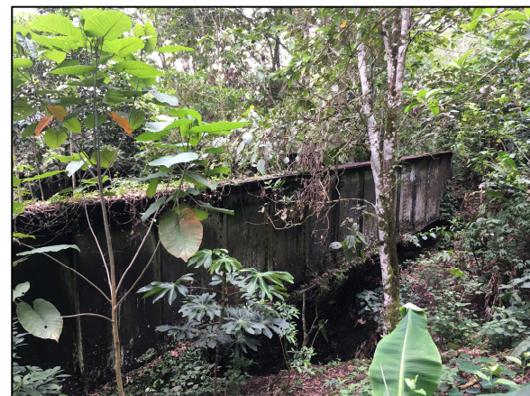
Figura 43. Punto 29. Puente 18m.
