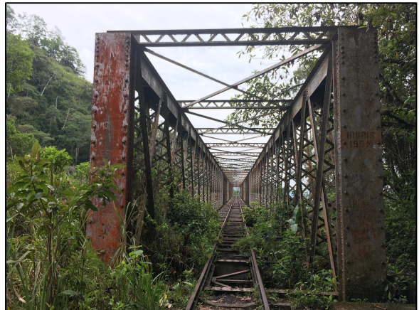
Figura 38. Punto 23. Puente sobre Río Birrís.
