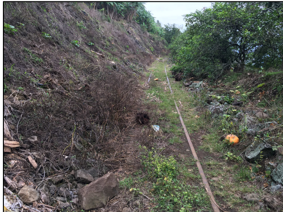
Figura 44. Punto 31. Derrumbe parcial sobre vía.
