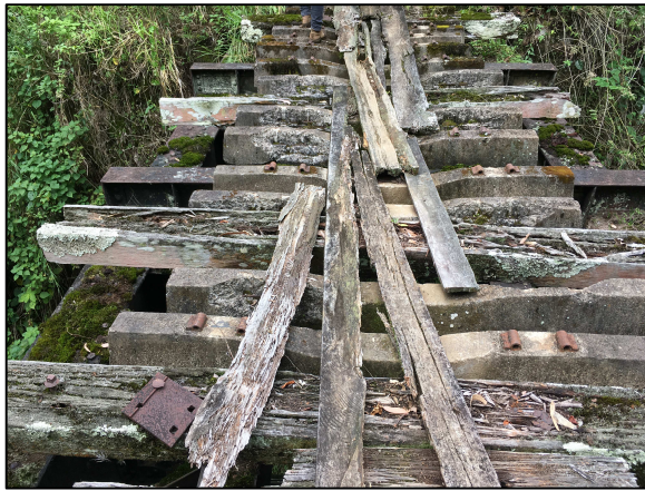
Figura 76. Durmientes de concreto sobre Punte.
