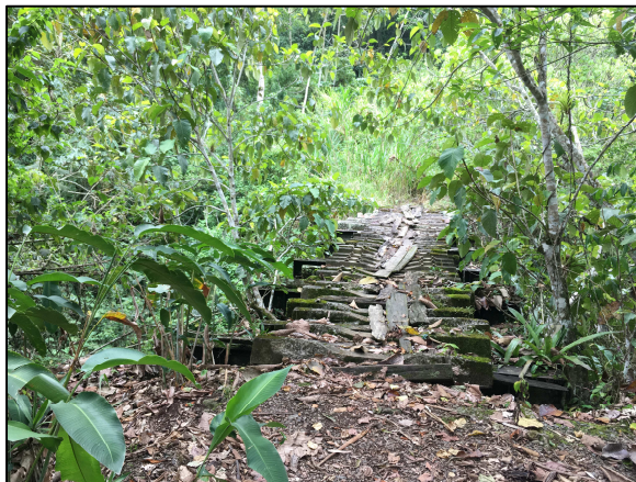
Figura 46. Punto 36. Puente sobre Quebrada Honda.
