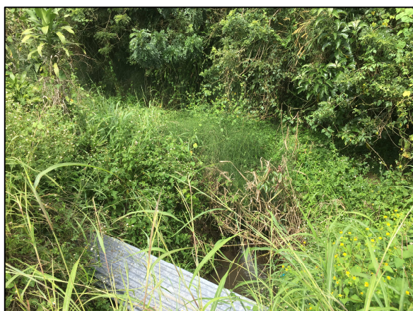
Figura 34. Punto 16. Paso de alcantarillas.
