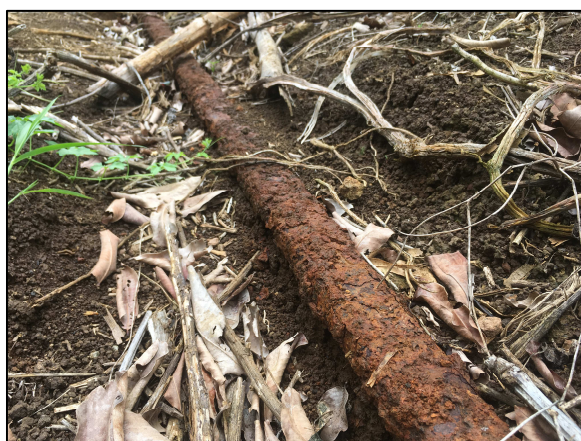
Figura 54. Estado de rieles en sector de cañales.
