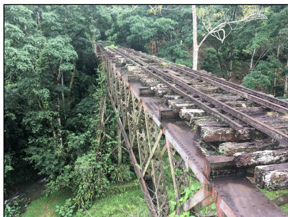
Figura 70. Punto 143. Puente 90m en Florencia.
