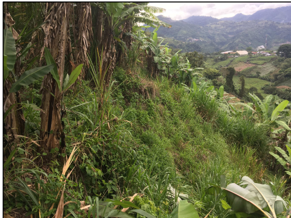
Figura 30. Punto 11. Inicio de derrumbe.
