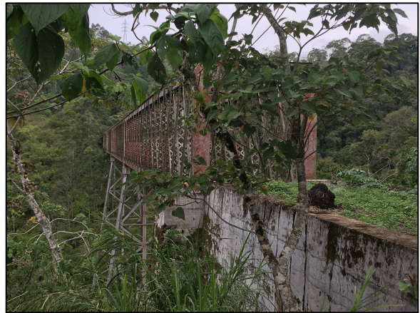
Figura 39. Punto 24. Puente sobre Río Birrís.
