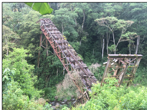
Figura 59. Punto 85. Puente sobre Río Chiz.
