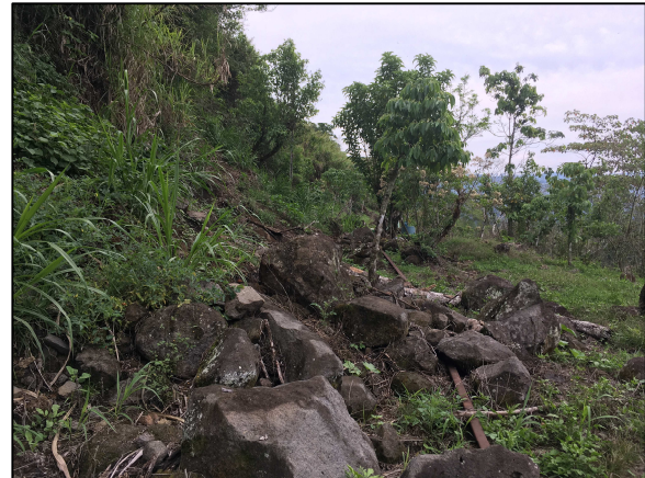
Figura 41. Punto 25. Deslizamiento sobre la vía.
