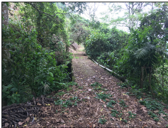
Figura 45. Punto 36. Puente 25m.
