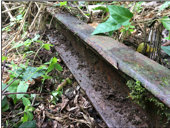
Figura 85. Rieles con agrietamiento.
