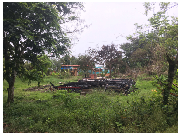
Figura 26. Punto 4. Antiguo edificio de estación. Actualmente quemado.
