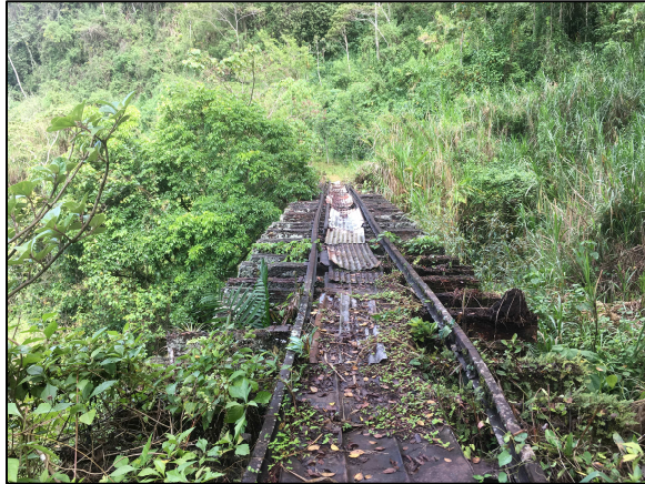
Figura 49. Puente 35m sobre Quebrada.
