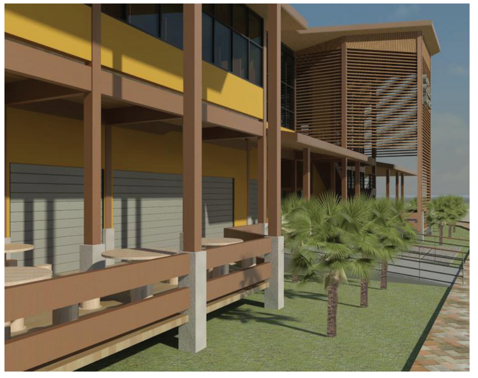
IMAGEN #127. VISTA DEL EDIFICIO A
