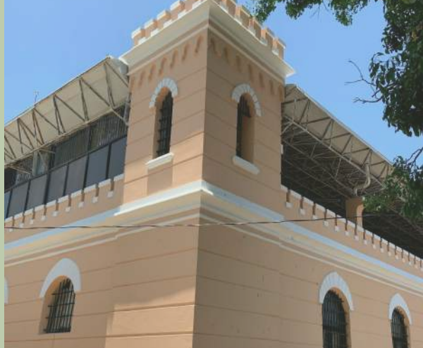
ANTIGUO CUARTEL Fecha de declaratoria: 1989. Período constructivo: finales del S.XIX y 1913. Características: Tipología militar que poseía con dormitorios, un patio central y celdas carcelarias.
