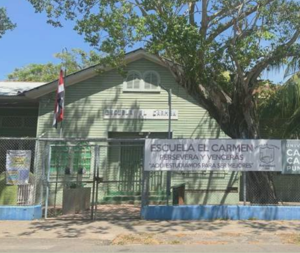
ESCUELA BARRIO EL CARMEN Fecha de declaratoria: 1990. Período constructivo: 194's Características: Edificación en madera, planta en U con patio central, corredores internos y cielos altos.
