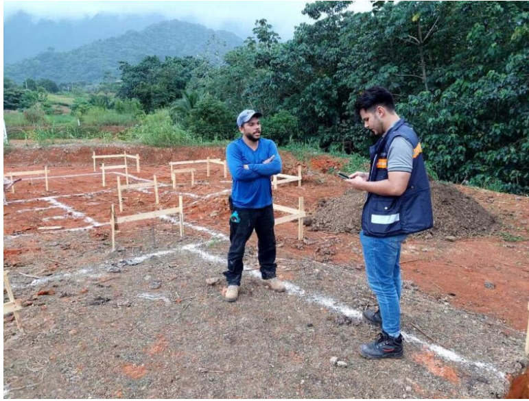
Figura B1. Evidencia de entrevista de campo 1 con maestro de obras.
