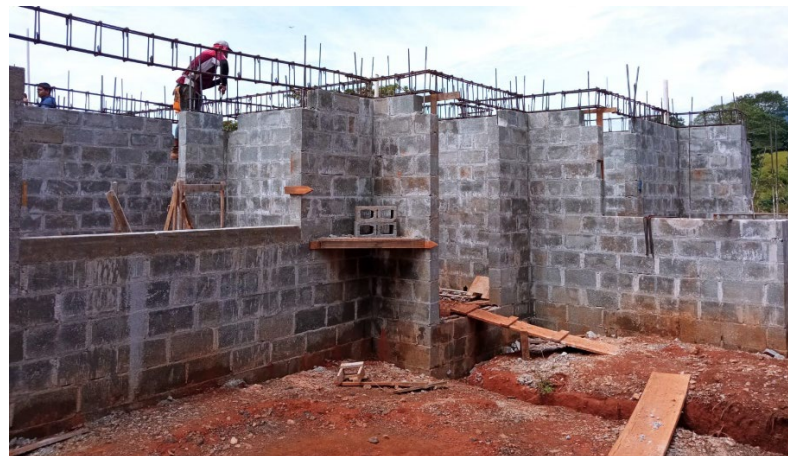
Figura 52. Avance del proyecto Fawcett, visita 3 (fotografía 1).
