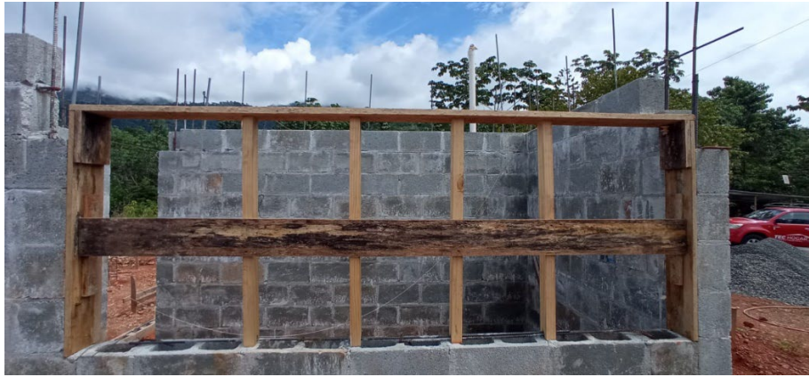
Figura 53. Avance del proyecto Fawcett, visita 3 (fotografía 2).
