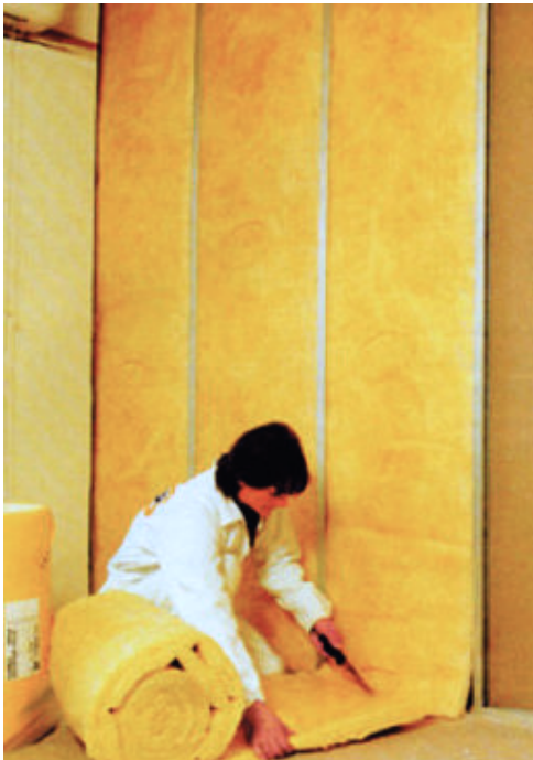
Figura 2.32 Fotografía instalación de lana de vidrio.
