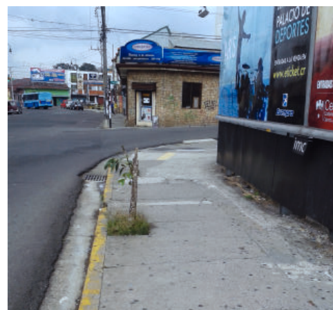
Figura 3-6 Fotografías del estado de las aceras en el contexto, Superior en excelente estado, Avenida 3 Calle 29-31; Media en mal estado Avenida 1, Calle 27-33. Inferior ejemplo del arborización dañada.
