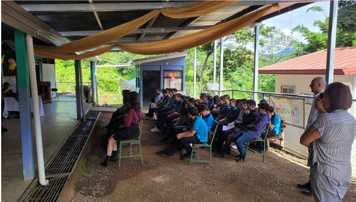
Fotografía de Instalaciones actuales de Liceo Rural Las Ceibas. Al fondo área de acceso restringido por derrumbamiento. Fuente: Propia
