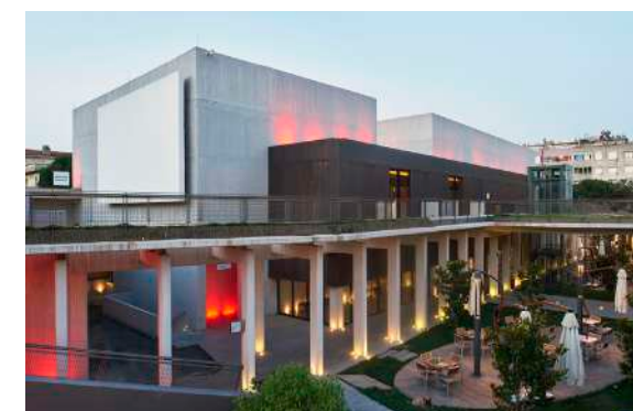
Imagen C1.116, Visualización del patio interno y el pasillo. Fuente: Plataforma Arquitectura, 2019
